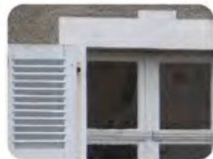
Encadrement en pierre de la baie
