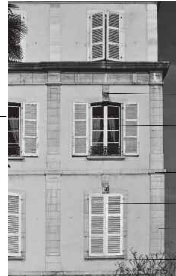
La travée latérale : pilastres en pierre, encadrements en pierre et linteaux surbaissés des baies surmontées d'une clef passante et sculptée. Les composants de la fenêtre : les garde-corps en ferronnerie, les contrevents à persienne et les menuiseries en bois à grands carreaux, sont peints..
