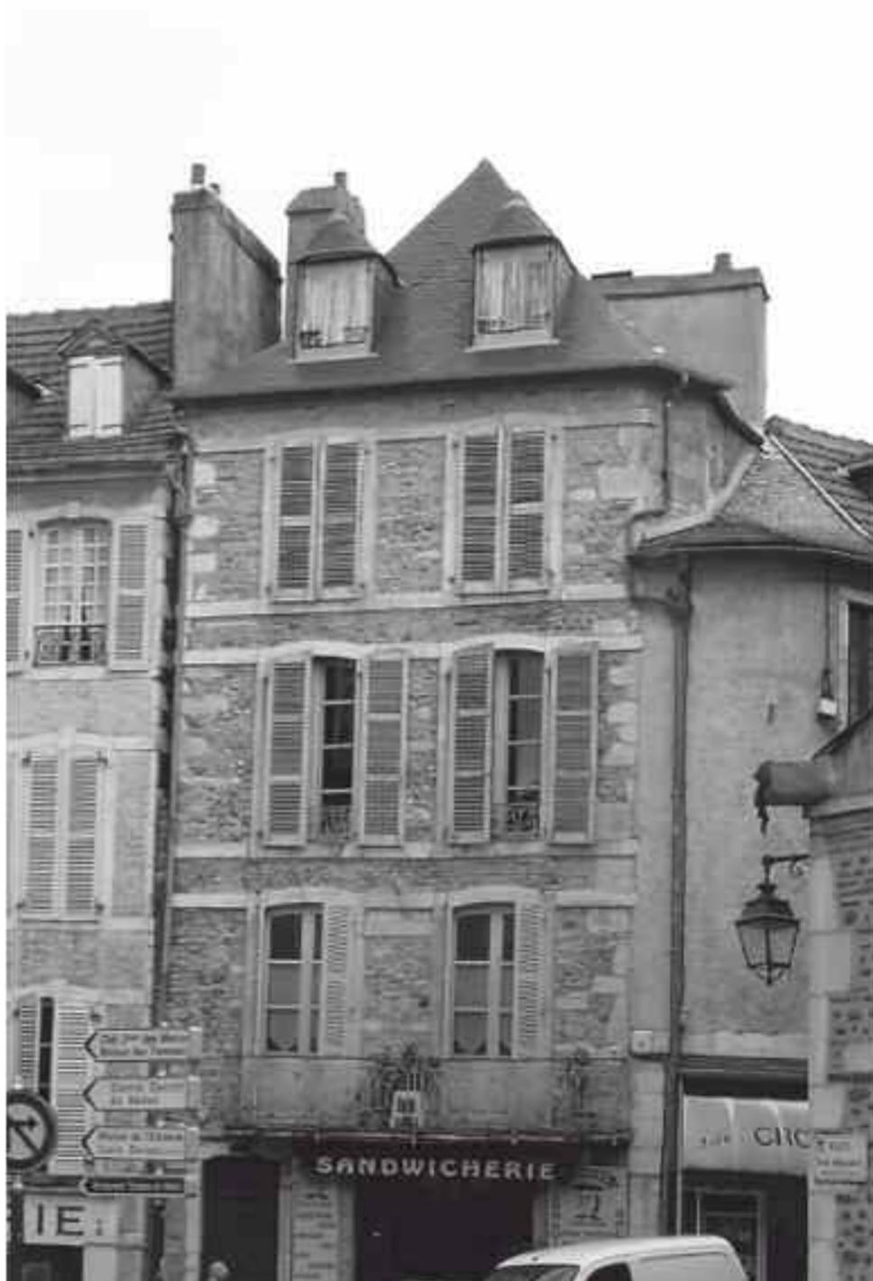
Photographie de l'état actuel : les murs ont été décrépis, laissant apparaître la maçonnerie de moellons et de briques et les chaînes d'angle montées en pierre non appareillées.
