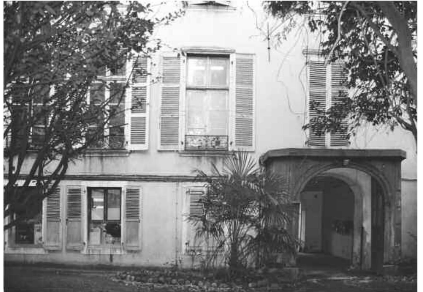
Photographies des façades sur cour : on peut remarquer qu'elles ont été un peu moins transformées que la façade sur rue, notamment l'aile en retour (photo de gauche) avec ses menuiseries à croisée en bois et à petits carreaux encore en place. Ces menuiseries peuvent servir de modèles pour une restitution sur la façade principale.
