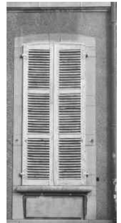
En rez de chaussée, les baies possèdent une allège en pierre. L'appui de fenêtre également en pierre est saillant. Sur le petit bâtiment, l'entresol s'ouvre sur des baies à deux niveaux. Les volets à persienne suivent cette logique et sont conçus en deux parties.
