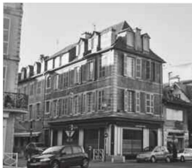
Grande maison à l'angle de la rue Henri IV et la rue Gassion. éléments de modénature (encadrements, bandeaux, chaîne d'angle en enduit et peinte) et les menuiseries de fenêtres des étages et des lucarnes sont encore en place. Le rez de chaussée a été remanié au XIX<sup>ème</sup> siècle avec l'ajout d'une devanture en bois.
