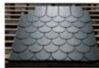
■ l'ardoise artificielle en fibres-ciment,
