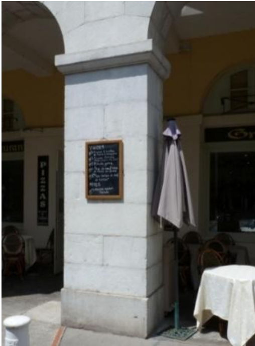
Le porte-menu en ardoise est cloué dans un joint de l'appareil en pierre de taille du pilier et ne dégrade pas la pierre.
