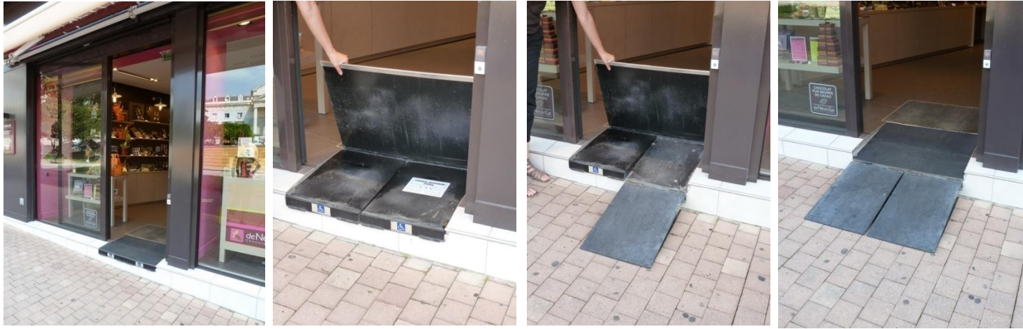
Marche/rampe intégrée dans le seuil de la porte- porte coulissante
