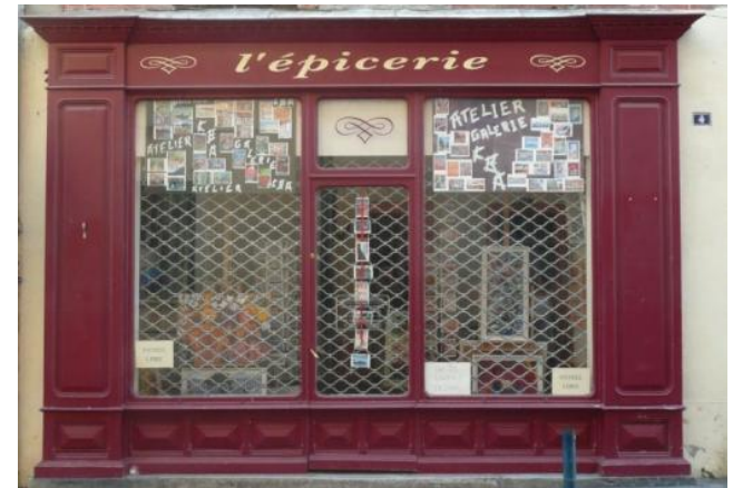
Systèmes de rideau ou de grille implantés derrière la vitrine et qui laisse passer le regard.
