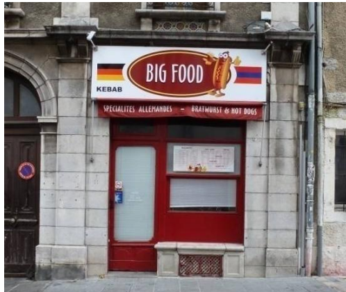
Petite devanture en feuillure, type fin XIX e intégrée dans le soubassement en pierre de taille. Problématique de la nouvelle enseigne hors d'échelle et qui déborde sur les éléments de modénature du soubassement. Rue Lamothe
