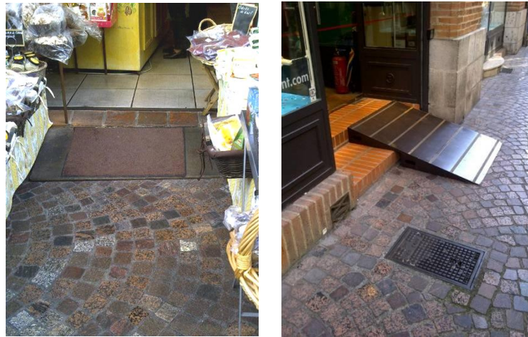
Systèmes de rampe amovible en bois et en métal
