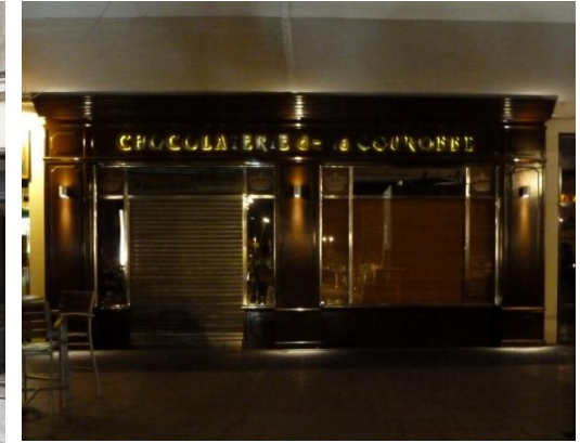
Eclairage mixte : éclairage très discret de la devanture et lettres lumineuses de l'enseigne
