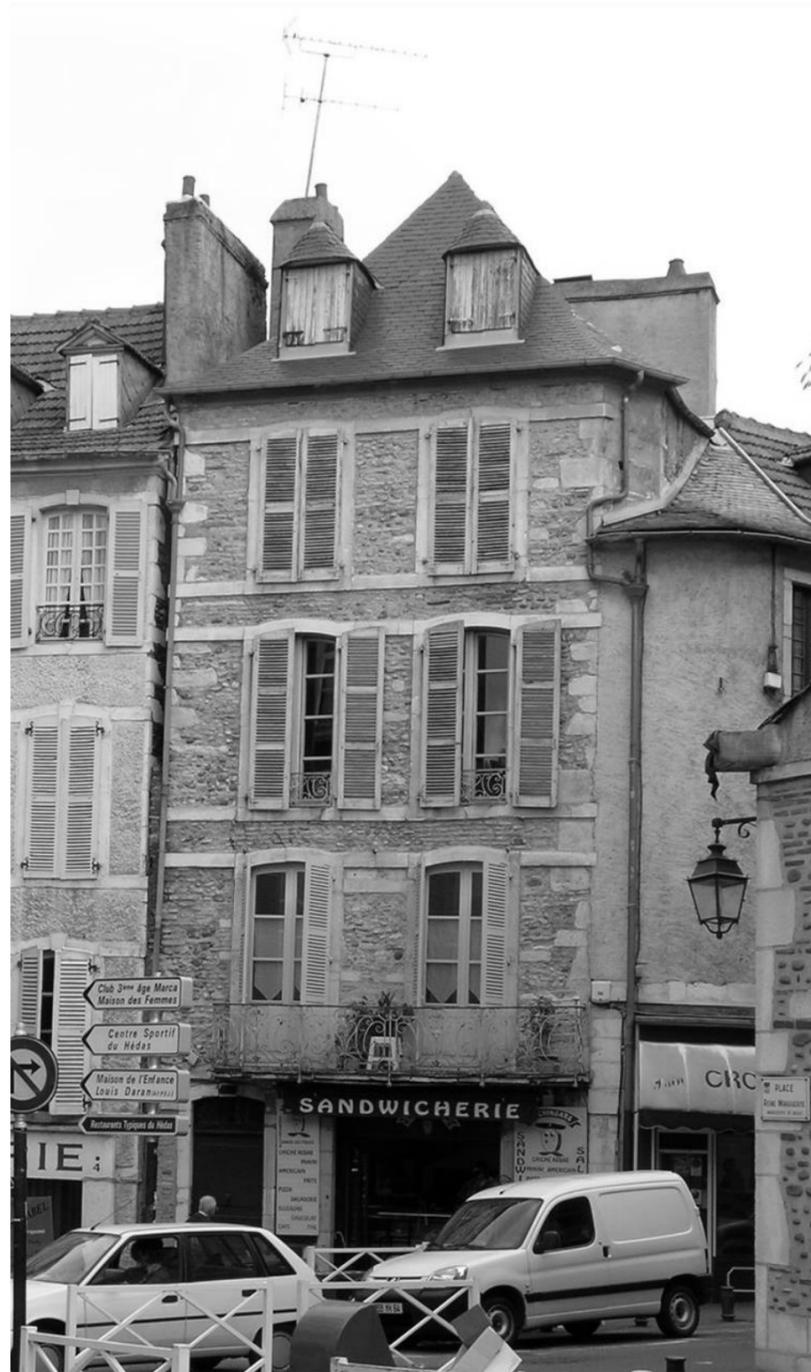
Photographie de l'état actuel : les murs ont été décrépis, laissant apparaître la maçonnerie de moellons et de briques et les chaînes d'angle montées en pierre non appareillées.
