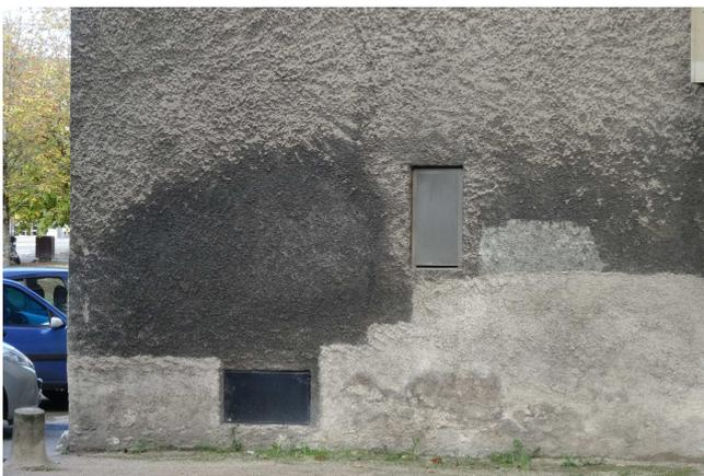
L'enduit ciment imperméable empêche l'eau des remontées capillaires de s'évacuer naturellement des maçonneries. L'eau emprisonnée dans le mur que l'on visualise par les auroles sombres au bas des murs met en péril la maçonnerie et rend le logement humide entraînant un inconfort thermique et des problèmes sanitaires. La pression exercée par les remontés capillaires peut faire migrer l'eau captive jusqu'à dans le mur peut remonter jusqu'à 7-8 mètres de hauteur.
