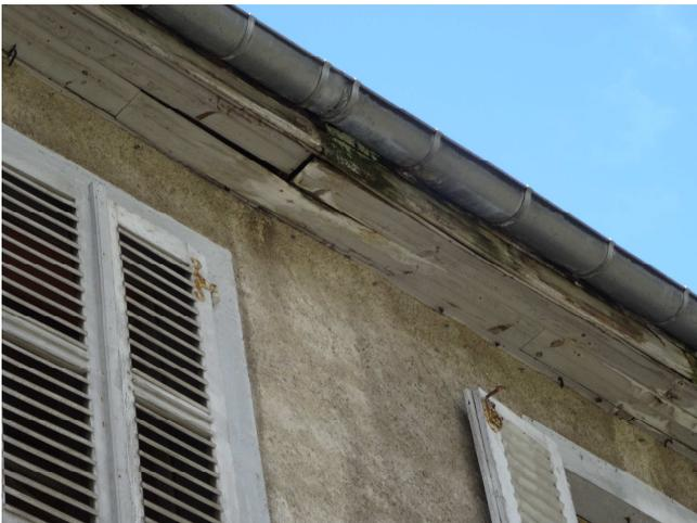
Une fuite dans la gouttière ou l'accumulation de feuilles mortes entraîne la destruction de la corniche en bois pénètre dans la maçonnerie et engendre de graves désordres dans la maçonnerie
