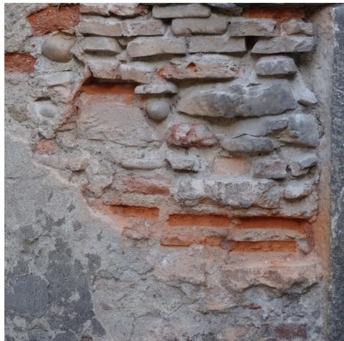
Les remontées capillaires favorisent l'efflorescences de sels qui désagrègent les matériaux des maçonneries (érosion chimique). La destruction du matériau est accentuée par le défaut d'enduit qui le protège de l'érosion éolienne.
