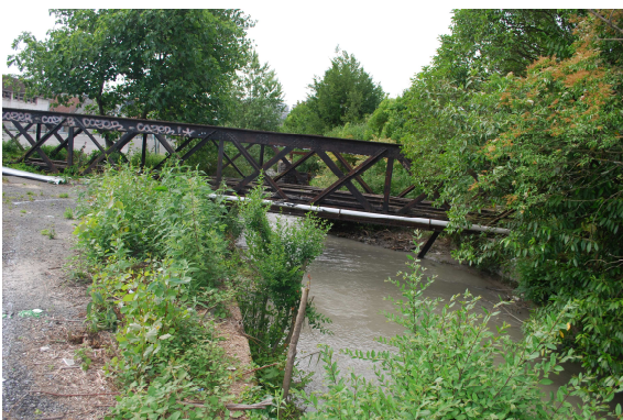
Pont métal sur le canal Heid. Des liaisons du chemin de fer vers les usines.
