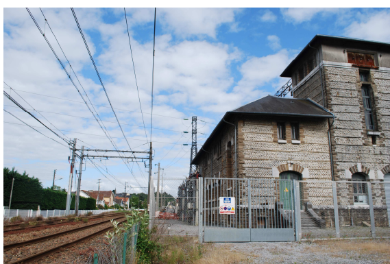
Le transformateur et le chemin de fer. Architecture de pierre du gave (galets) et brique.
