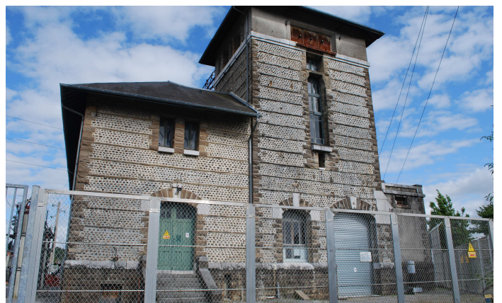
Le transformateur de la société électrique.
