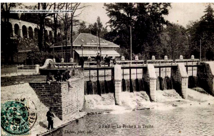
Les écluses, face à la gare.
