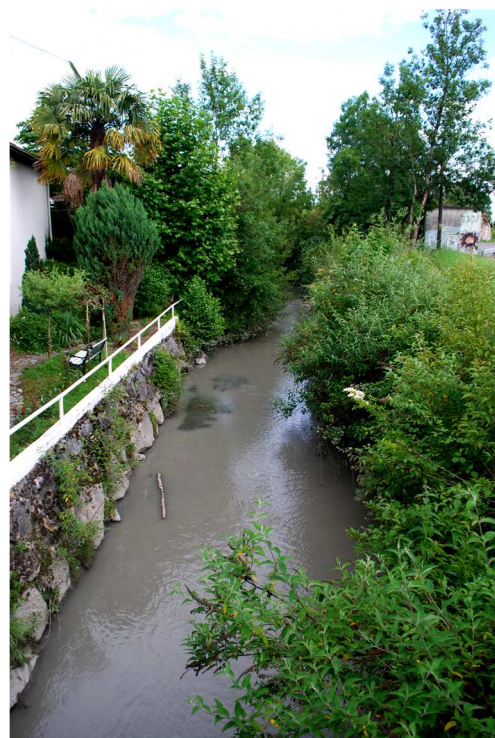
L'ancien canal qui permettait de faire tourner un ancien moulin, propriété de Mr. Boudon, (voir n° 4 plan dessus).
