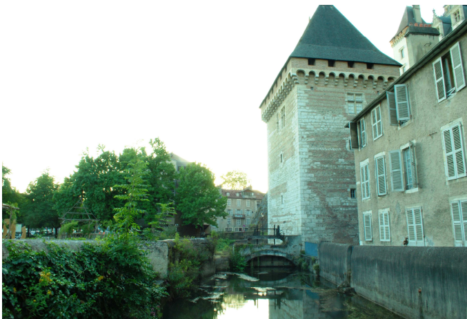
La tour de la Monnaie et le canal du Moulin.
