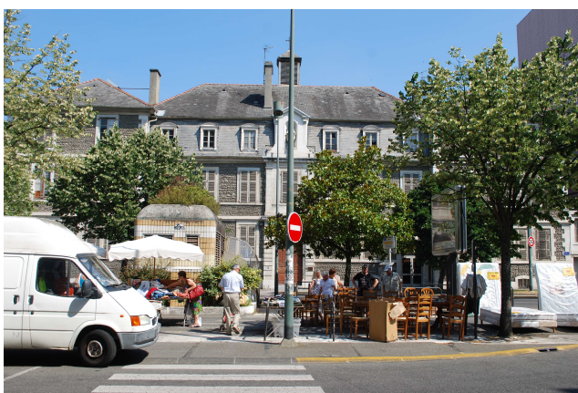
Immeuble de la Miséricorde (ESAC), Place Marguerite Laborde. L'abondance d'éléments cache la lecture du bâti.
