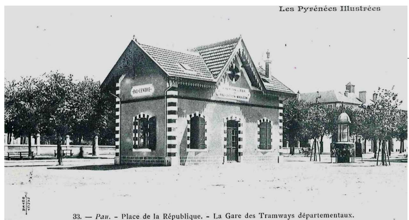
La gare des tramways départementaux, face au marché. En deuxième plan les allées de la place des écoles.
