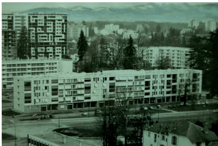
154 Barres parallèles à l'axe de principal. Résidence Dufau / Source: ACAPP
