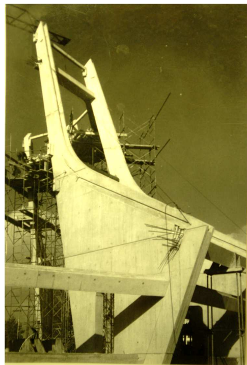
Pilier en béton coulé de l'église Saint-Pierre. Construction 1969. Sources: ACAPP
