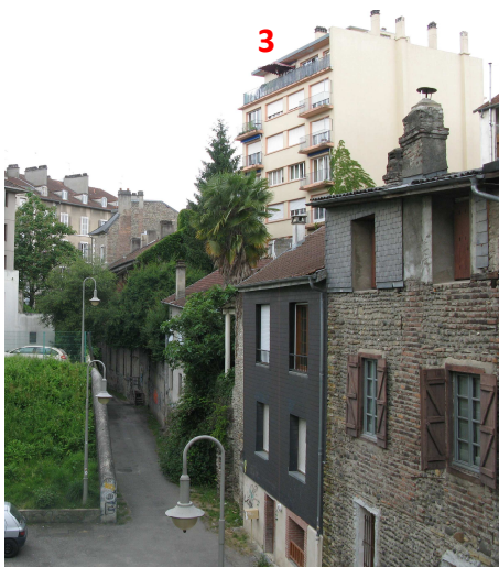
Le registre des façades arrière sur le fossé du Hédas, : les bardages
