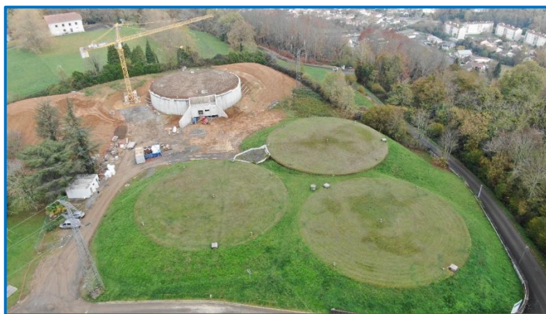
Figure 6. Site de Guindalos : 4 réservoirs de 5 000 m 3
