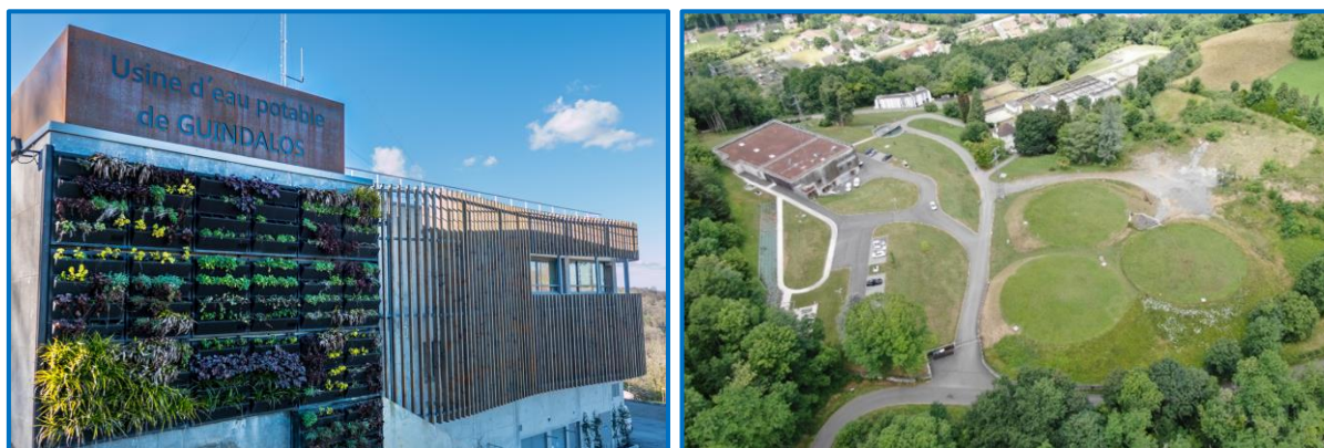
Figure 5. Site de Guindalos : nouvelle usine et réservoirs
