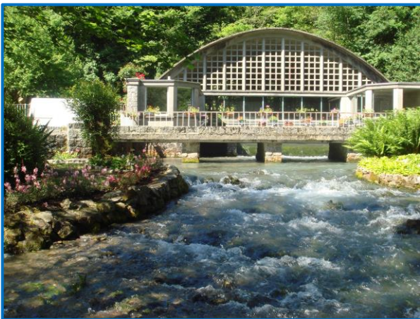
Figure 3. Captage de l'Oeil du Nééz
