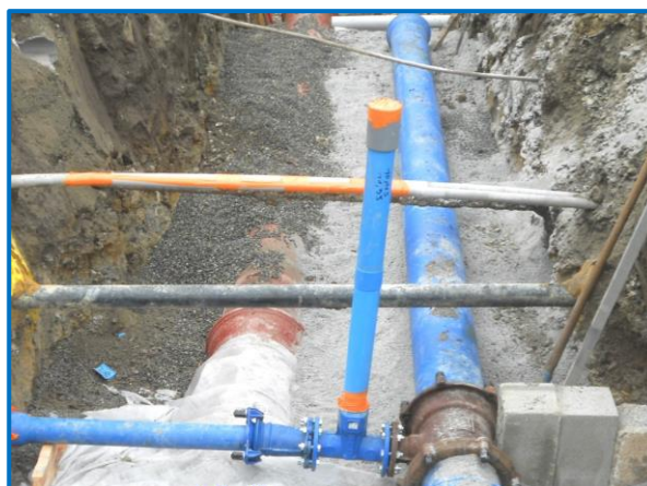
Figure 8. Travaux de renouvellement de réseaux
