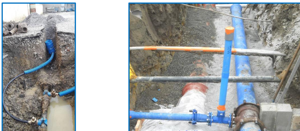
Figure 8. Travaux de renouvellement de réseaux
