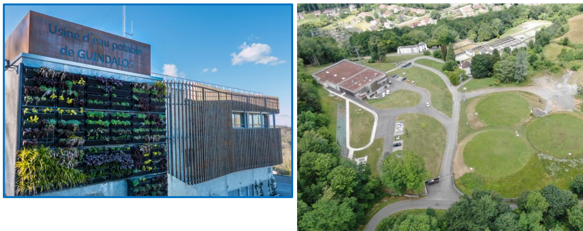
Figure 5. Site de Guindalos : nouvelle usine et réservoirs
