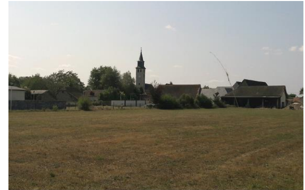
Secteur à urbaniser en centre bourg
