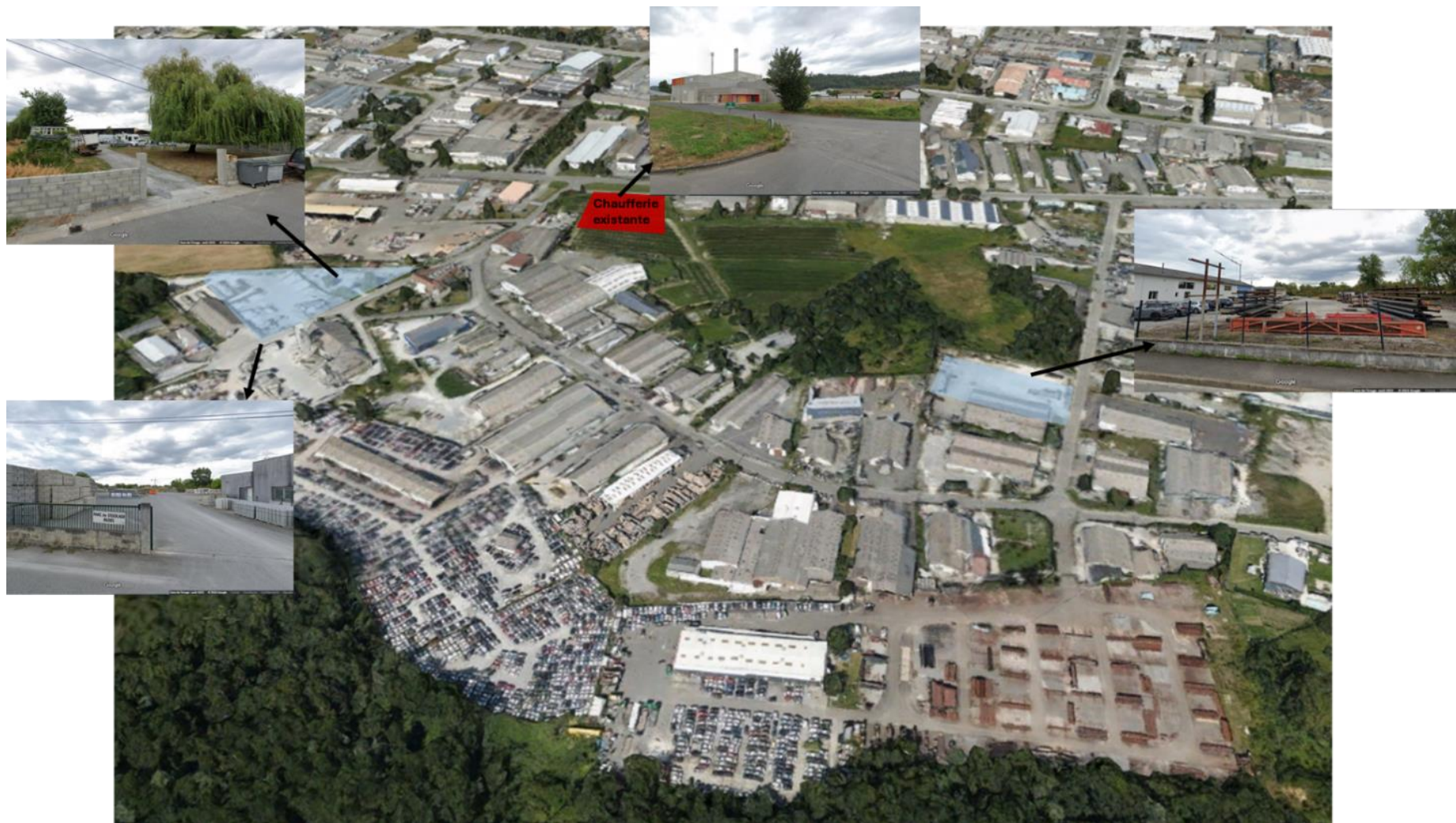
Illustration du caractère très artificialisé du secteur concerné par la modification n°4 du PLUi.
