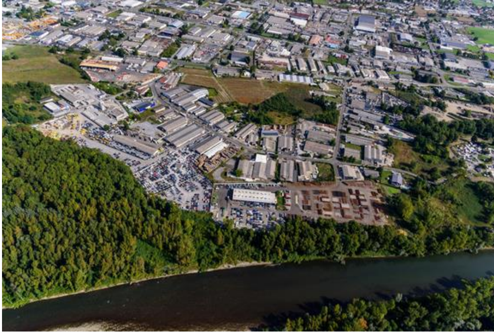
Photos du secteur Monhauba dans la ZAE Induslons (source : P. Glorieux, octobre 2016)
