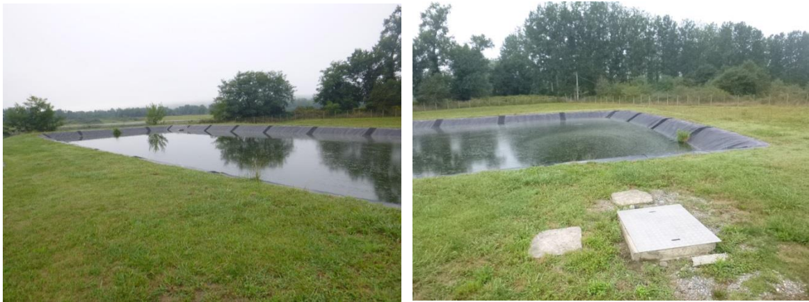
Figure 10 : Photo du bassin de finition
