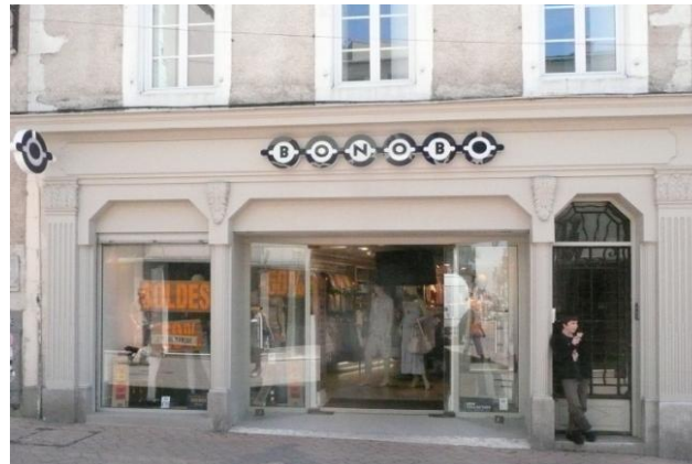
Rez de chaussée avec devanture en applique style Art déco (années 1920- 1930) qui intègre la porte d'entrée de l'immeuble. Rue Saint Jacques.
