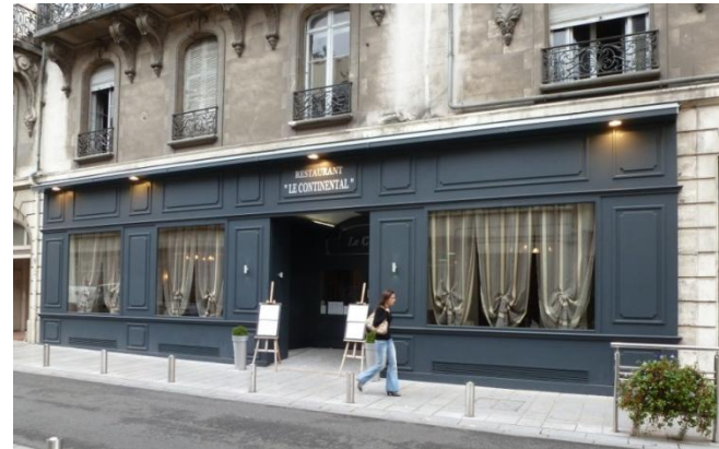
L'éclairage par l'extérieur souligne l'enseigne mais aussi le rythme architectural de la devanture
