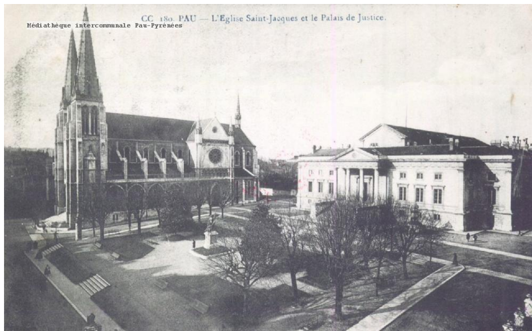
L'église St. Jaques et le Palais de Justice. 191 ? Actuelle place de la Libération. 19 ? Réseau des médiathèques de l'agglomération Pau Pyrénées. Patrimoine numérisé. Cote : 8-091-3
