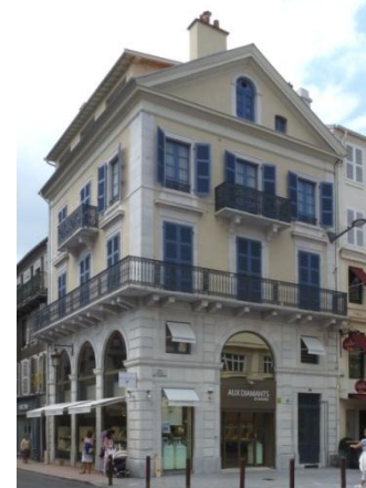
Exemple s de devanture entre rez de chaussée et entresol
