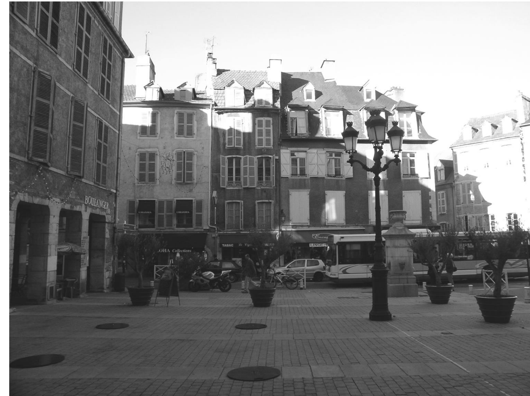
Les façades au Nord, datant du XVII e , XVIII e et XIX e siècles, s'alignent sur un parcellaire étroit. Ce rythme est actuellement peu perceptible. La prescription architecturale tend à retrouver ce rythme et à restituer chaque façade selon son style et son époque de construction.
