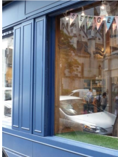
Ci-dessus, le rideau est intégré derrière les panneaux en bois
