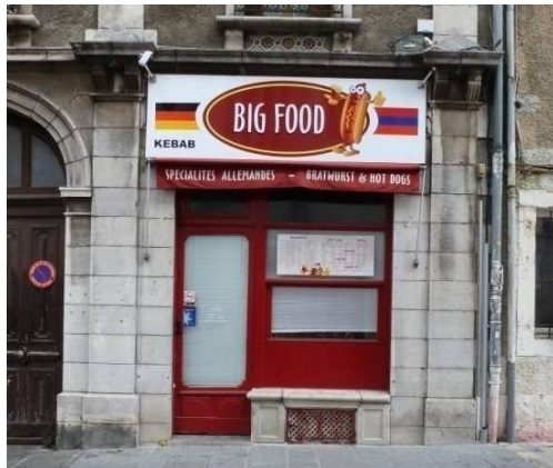
Petite devanture en feuillure, type fin XIX e intégrée dans le soubassement en pierre de taille. Problématique de la nouvelle enseigne hors d'échelle et qui déborde sur les éléments de modénature du soubassement. Rue Lamothe
