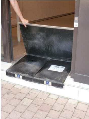
Marche/rampe intégrée dans le seuil de la porte- porte coulissante
