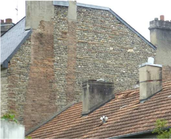
Maçonnerie de galets avec assises de briques. Maçonnerie des conduits de cheminée en brique.
