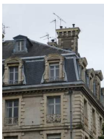
L'ardoise en couverture, la pierre pour former la lucarne
