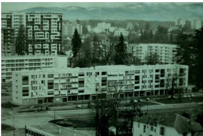
154 Barres parallèles à l'axe de principal. Résidence Dufau I Source: ACAPP
