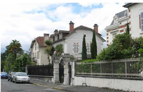
Murs de clôture assurant la continuité urbaine
