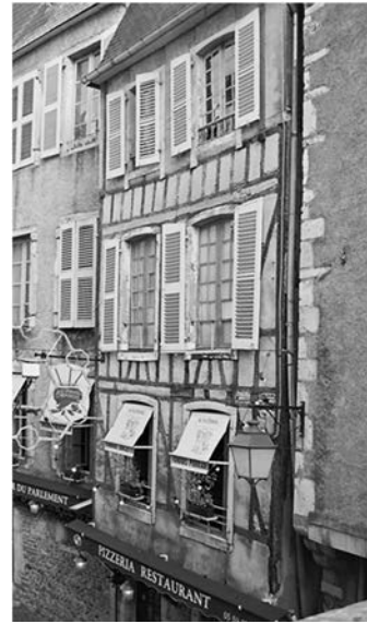
Enduire pour protéger les façades en maçonnerie de galet et le pan de bois simple (ici à grille)
