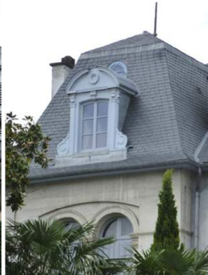
Lucarnes à fronton courbe et ailerons en bois, toit bombé. Les jouées sont bardées d'ardoise ou de zinc
