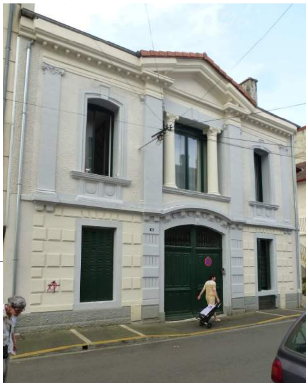
Façade de typologie classique en ciment, éléments de modélure ciment moulé. Années 1920-1930
