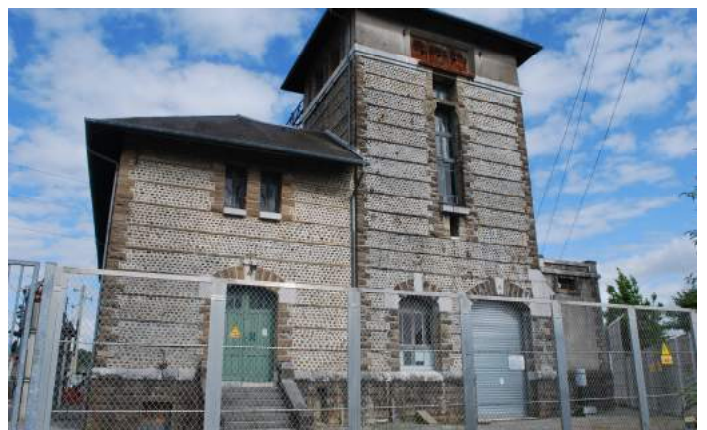
Le transformateur de la société électrique.
