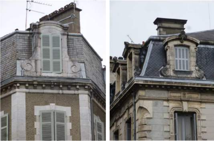
Lucarnes à fronton courbe, à ailerons et amortissements en pierre et toit bombé.
