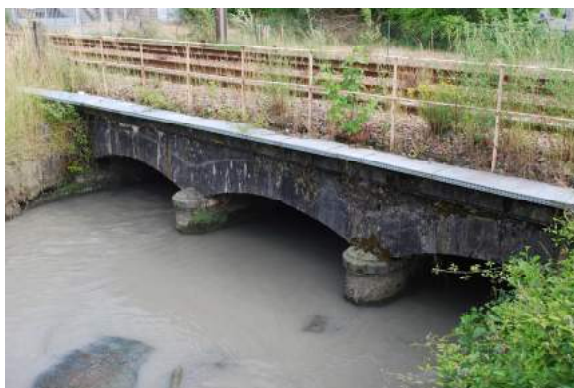
Les ouvrages d'art et ses matériaux. Pont sur le canal Héid, chemin de fer.
