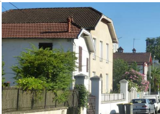
La tuile de Marseille, les cheminées et les éléments de décor en terre cuite
