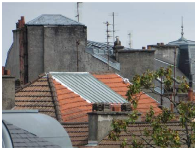
Cheminées , prises de jour et verrières
