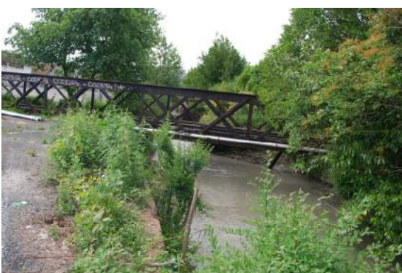
Pont métal sur le canal Héid. Des liaisons du chemin de fer vers les usines.
