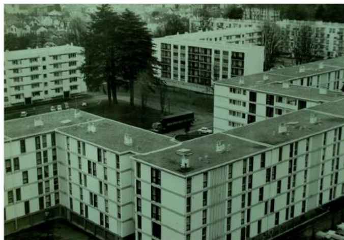
Barres en zig-zag, création d'espaces intimes propres à chaque bâtiment (espaces semi-publics). Résidence Camors. Source: ACAPP
