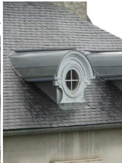
Lucarne de type œil de bœuf, couverture zinc
