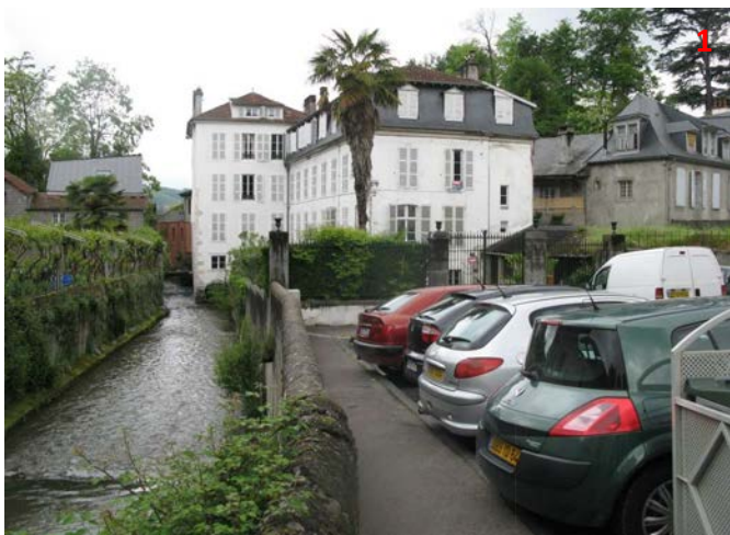
Canal au niveau de la rue des Moulins et au niveau de la place de la Monnaie
