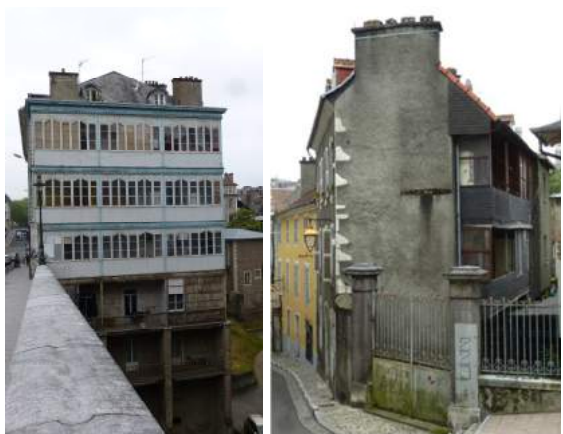
Façades arrière sur jardin, avec galeries vitrées, bardage ardoise ou construction bois
