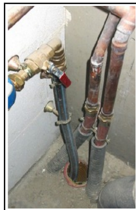
Exemple d'entrées de réseaux à calfeutrer
