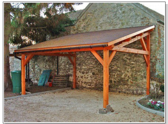
Abri de protection accolé à bâtiment (adjonction)
