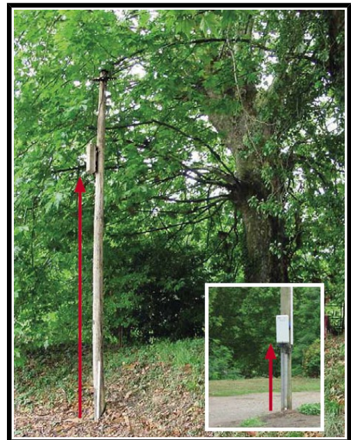
Exemple de mise hors d'eau de compteur électrique
