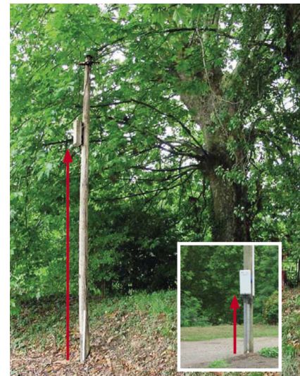
Exemple de mise hors d'eau de compteur électrique
