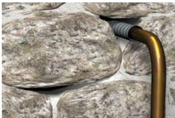
Situation initiale avant colmatage
