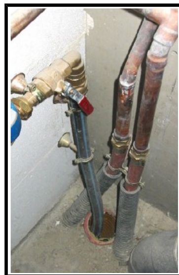
Calfeutrage des entrées de réseaux
