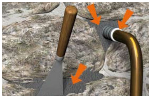
Situation après travaux de colmatage
