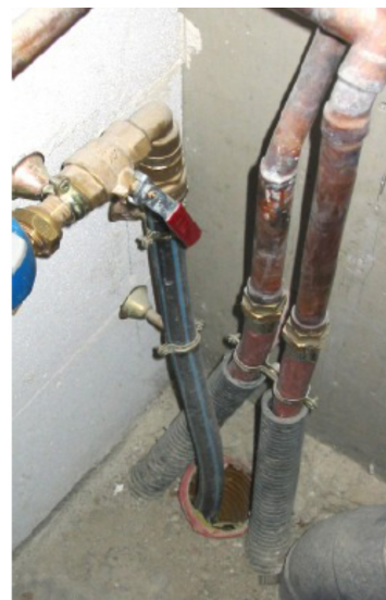
Calfeutrage des entrées de réseaux
