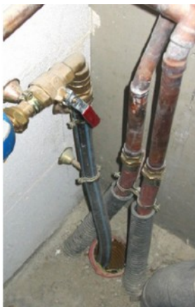
Exemple d'entrées de réseaux à calfeutrer
