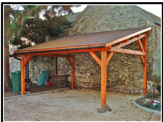
Construction annexe adossée
