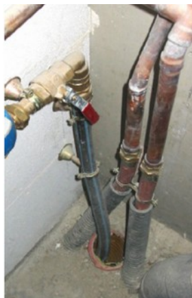
Exemple d'entrées de réseaux à calfeutrer
