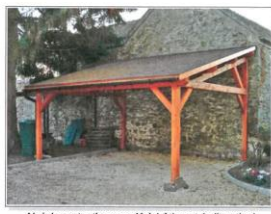
Abri de protection accolé à bâtiment (adjonction)
