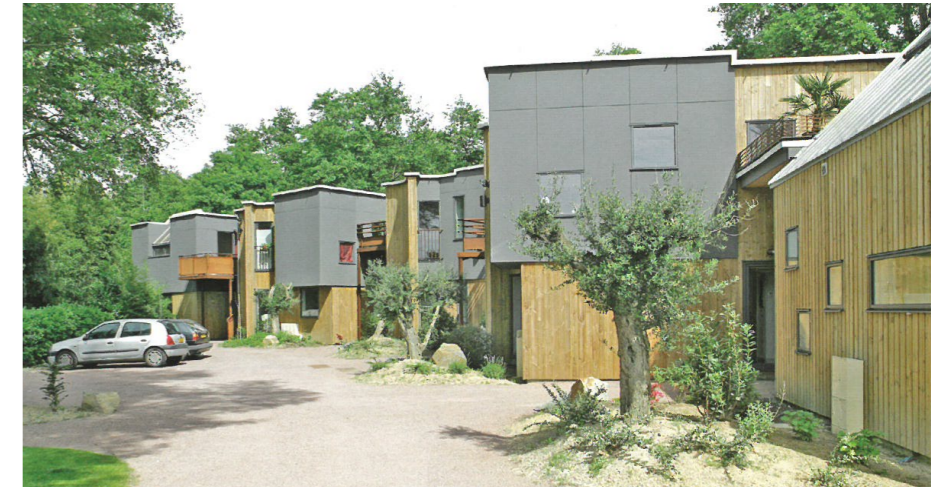
Un parking paysager qui ménage une transition subtile vers les logements, le clos de l'Erdre à Nantes
