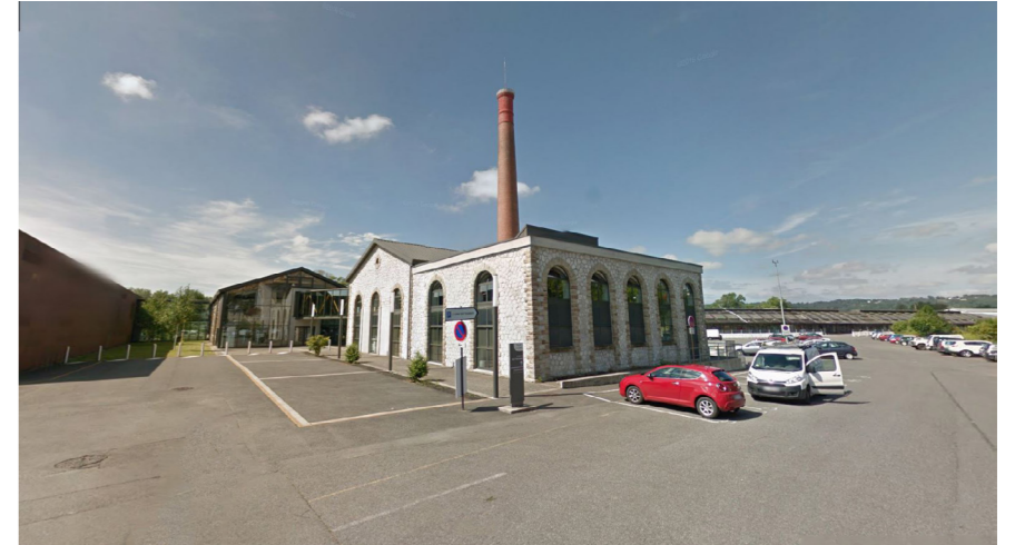
Ancien bâtiment industriel réhabilité en bureau près de la gare de Pau
