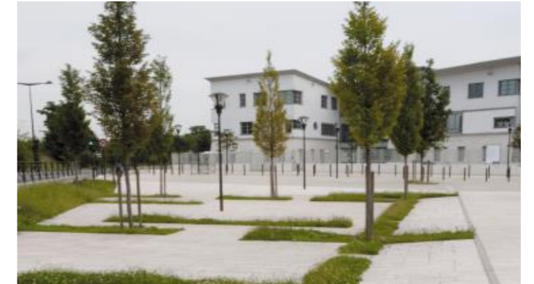
Intégrer l'écoulement des eaux pluviales dans la conception du projet en tenant compte et en exploitant la topographie.
