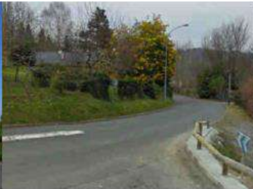
Sortie du chemin Péhourticq sur la rue Pierre Bidau
