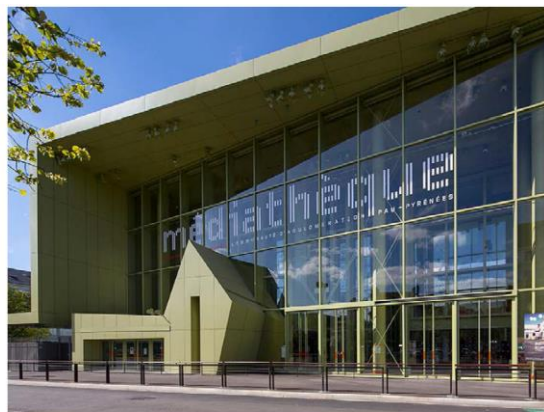
Médiathèque intercommunale André Labarrère
