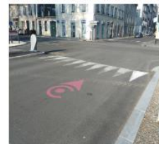
une matérialisation au sol
