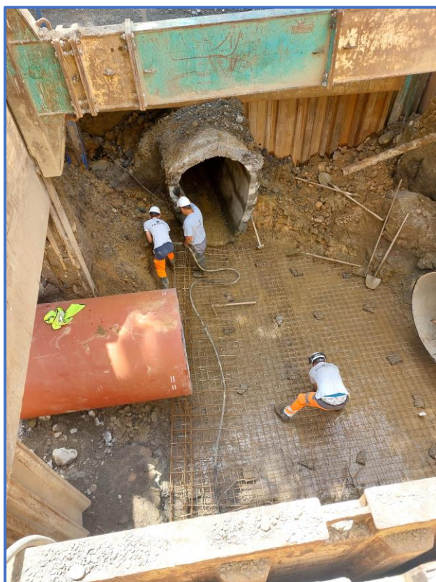
Travaux de création d'une chambre de raccordement des réseaux de délestage au droit du pont d'Espagne à Pau
