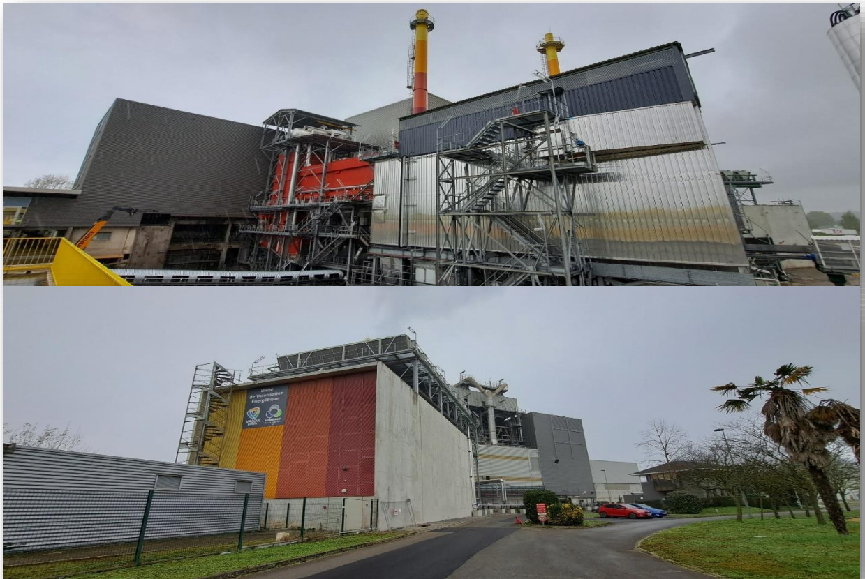
Ligne de four n°5 et bâtiment du Groupe Turbo-Alternateur (aérocondenseurs sur le toit)
