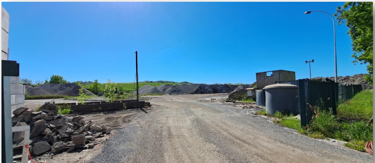
Plateforme des graves de mâchefers d'incinération exploitée par Cyclamen pour Béarn Urbaser Energie
