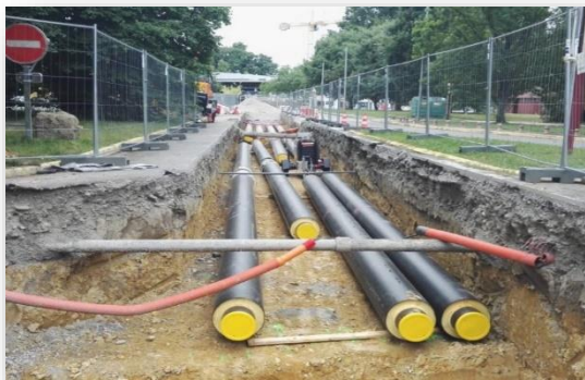
Mise en place du Réseau de Chaleur Urbain à Pau
