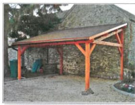
Abri de protection accolé à bâtiment (adjonction)
