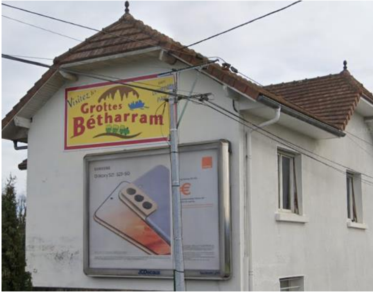
Route de Tarbes (dépassement de l'égout du toit)
