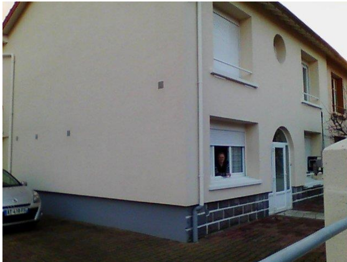
Mur avec isolation extérieure
