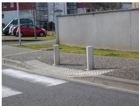
Traversée piétonne en conformité PMR Bizanos
