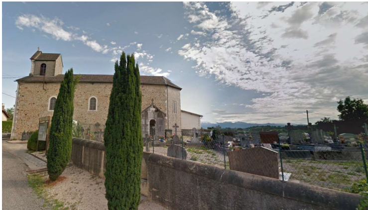
Chapelle de la Route de la Chapelle de Rouse à Jurançon – Source : Google Street View
