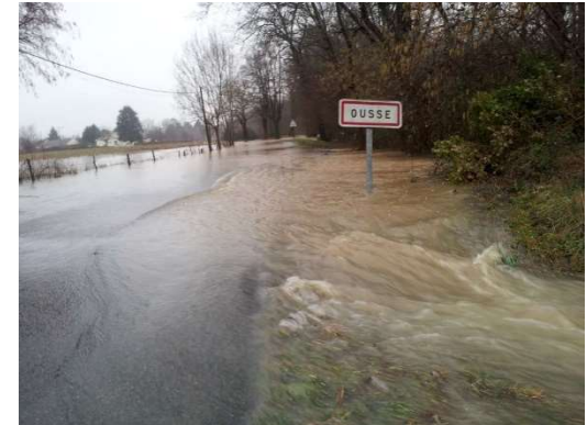
Des infrastructures vulnérables au risque inondations – Source : Sud Ouest
