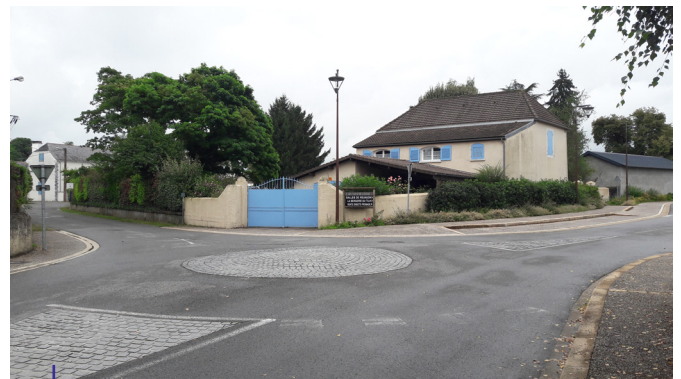
Aménagement d'un giratoire de petite taille, sécurisant et favorisant la pratique de la marche et du vélo - Artigueloutan Source : Audap
