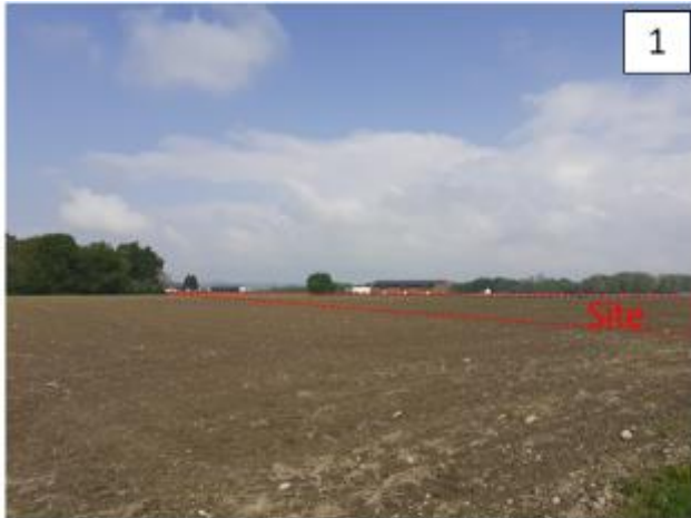
Vue depuis le chemin au sud-est des terrains du projet
