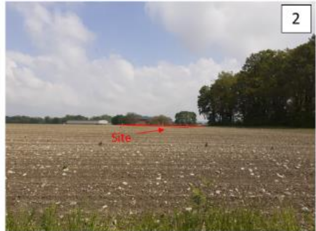
Vue depuis le chemin au sud-ouest des terrains du projet
