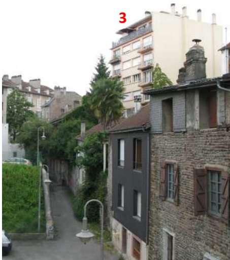
Le registre des façades arrière sur le fossé du Hédas, : les bardages
