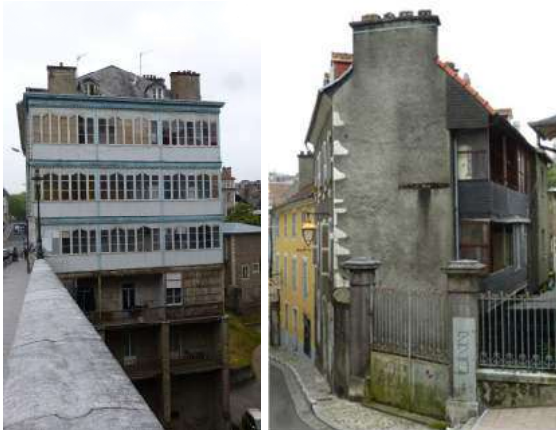
Façades arrière sur jardin, avec galeries vitrées, bardage ardoise ou construction bois
