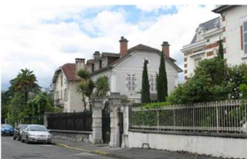
Murs de clôture assurant la continuité urbaine
