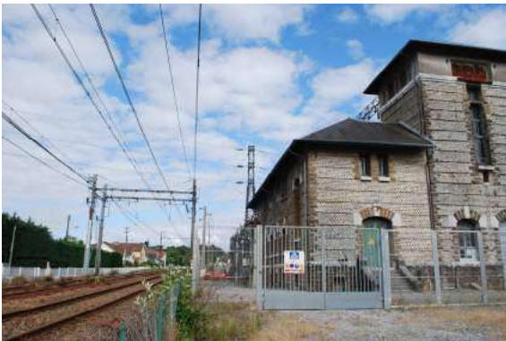
Le transformateur et le chemin de fer. Architecture de pierre du gave (galets) et brique.
