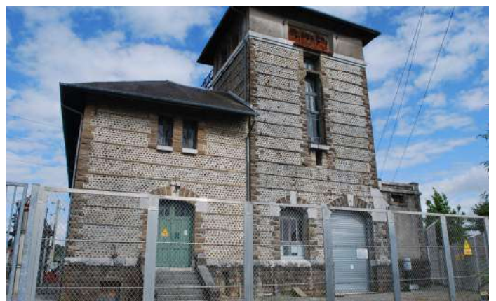
Le transformateur de la société électrique.
