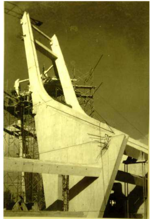
Pilier en béton coulé de l'église Saint-Pierre. Construction 1969. Sources: ACAPP
