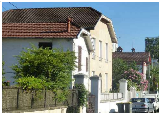
La tuile de Marseille, les cheminées et les éléments de décor en terre cuite
