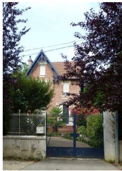
Façades en briques
