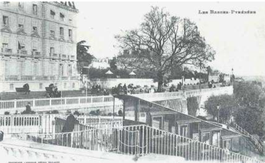
Boulevard des Pyrénées et funiculaire. Pau 1900 cartes postales. Le prolongement est du boulevard, le solarium.
