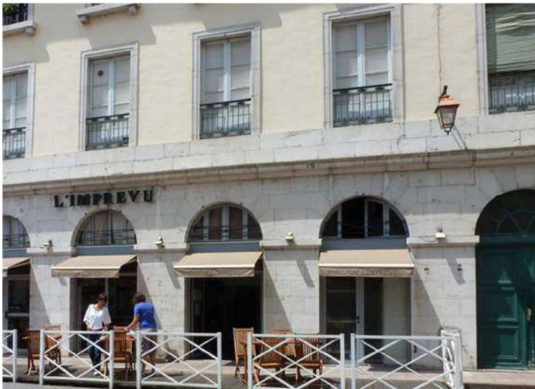
Restaurer la pierre de taille, enduire et colorer les murs
