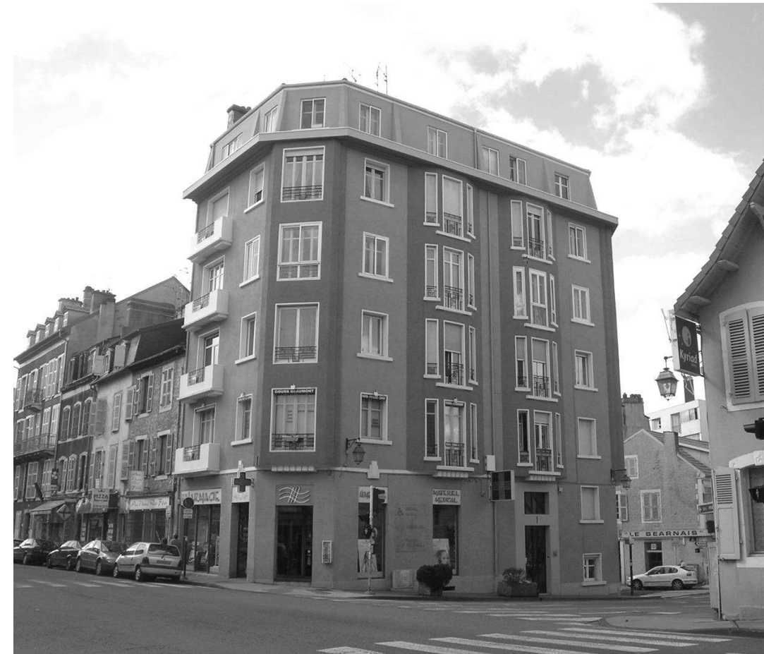
Immeuble rue Henri Faisans
