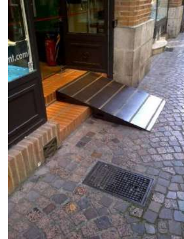
Systèmes de rampe amovible en bois et en métal
