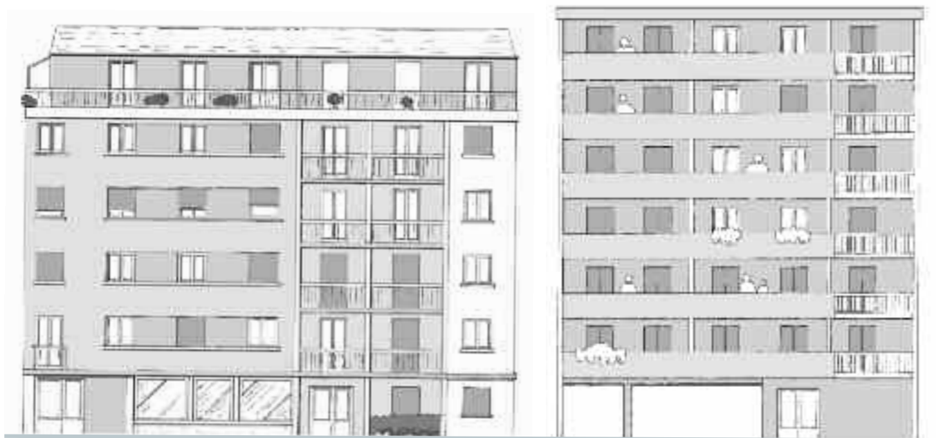
Sur ces deux façades, ce sont plutôt les éléments horizontaux qui ont été soulignés.
