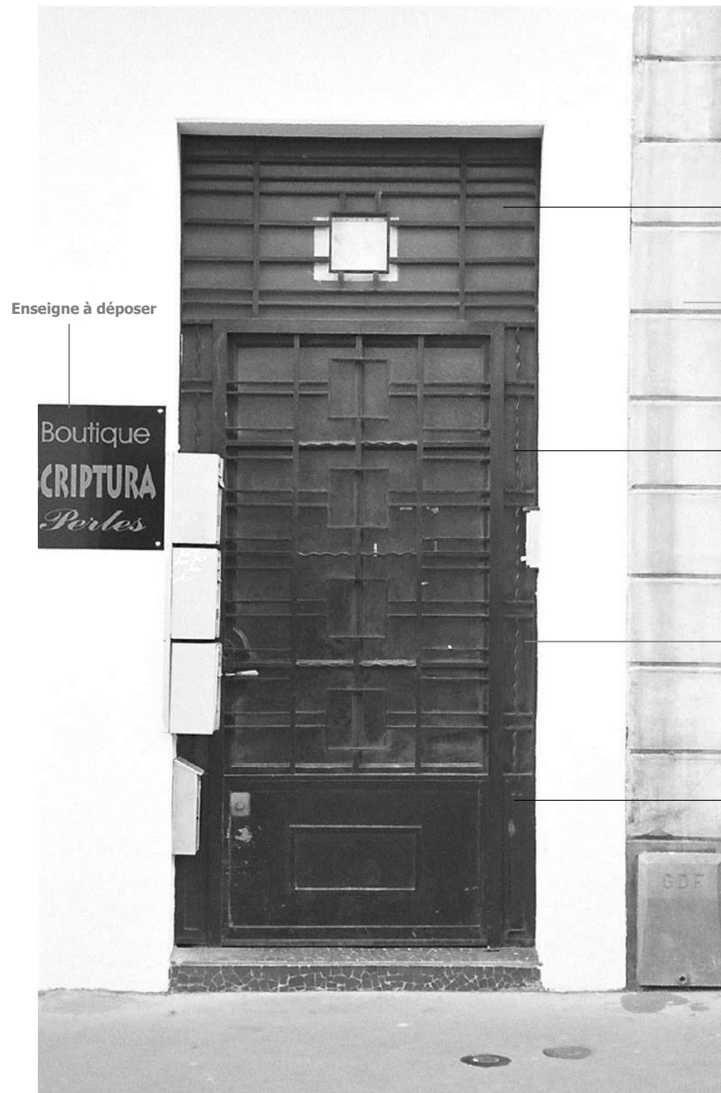
Détail de la porte d'entrée et de sa serrurerie
