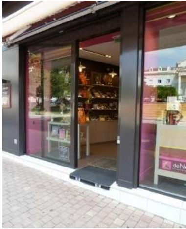
Marche/rampe intégrée dans le seuil de la porte- porte coulissante
