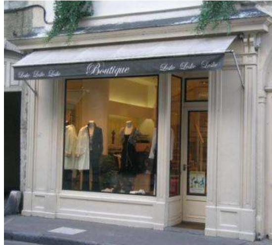
Devantures en applique, type fin XIX e , composée de panneaux en bois moulurés du soubassement à la corniche. Rue Henri IV.
