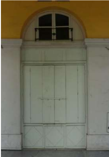
Systèmes de fermeture anciens : les ais en bois
