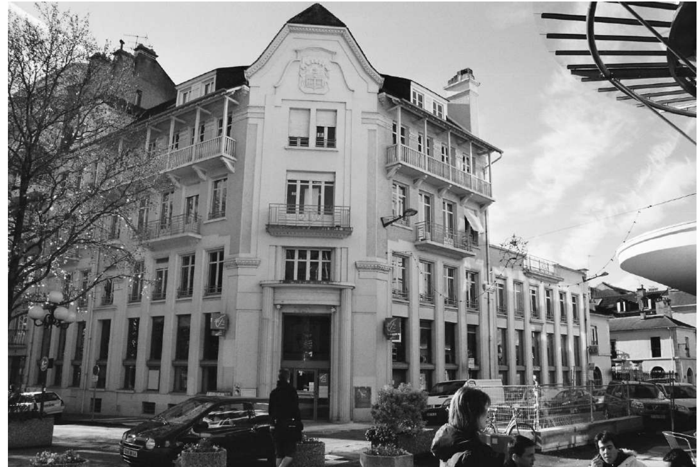
Immeuble de la CCI, rue Louis Barthou
