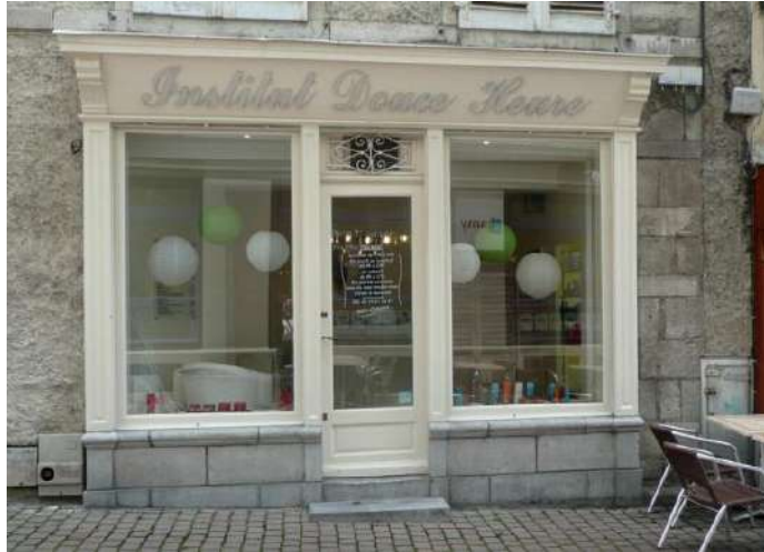
Devanture en applique, type fin XIX e , qui se distingue par le traitement du soubassement en pierre de taille et une corniche en bois moulurée. Rue Sully.
