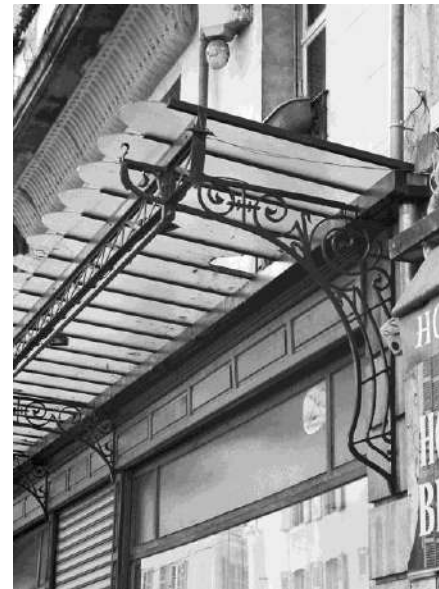
Exemples de marquises anciennes : dessins des supports, légèreté des ouvrages
