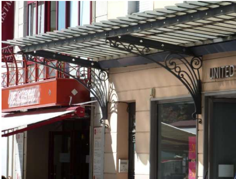
Exemples de marquises anciennes : dessins des supports, légèreté des ouvrages
