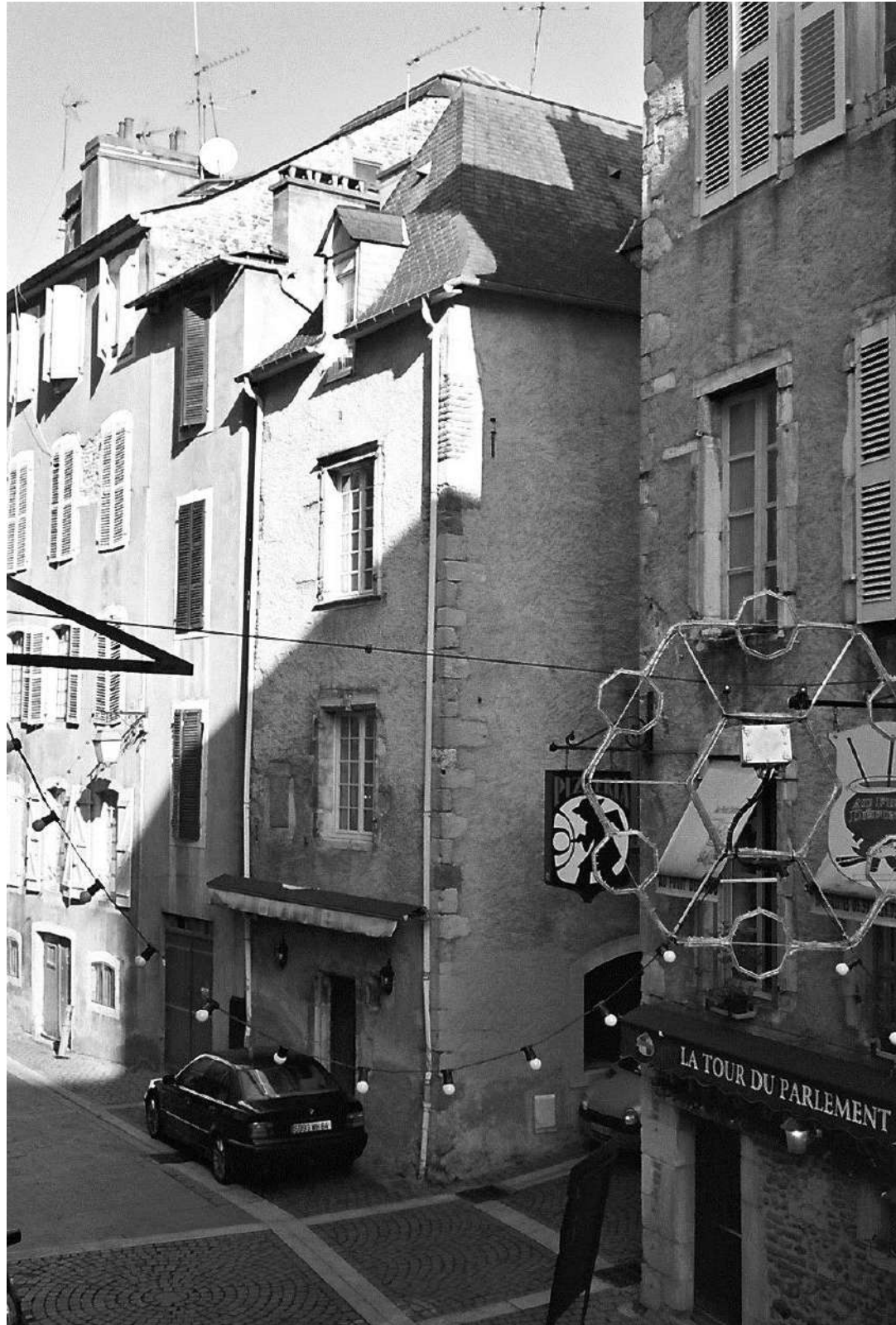
Façade rue du Moulin
