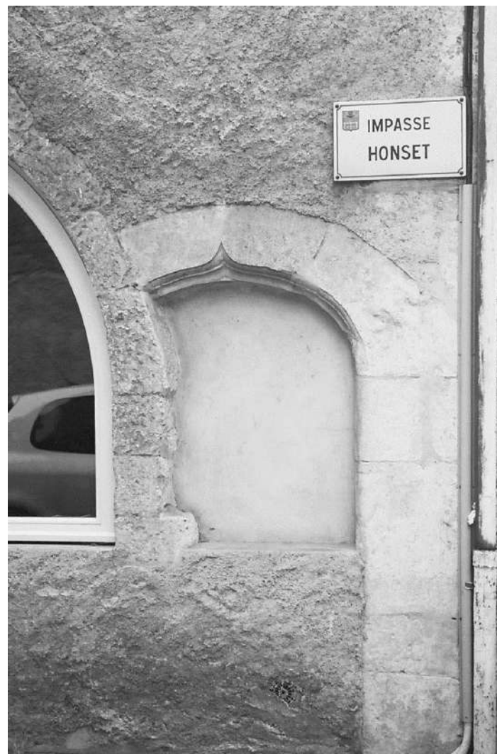
Détail de la baie située façade Est, arc en anse de panier à accolade
