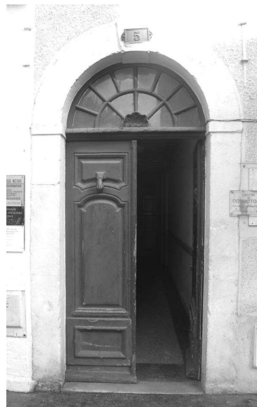
Type de menuiserie de porte à deux battants en bois à moulure et peint. Imposte vitrée et heurtoir en fonte. Place Saint Louis de Gonzague
