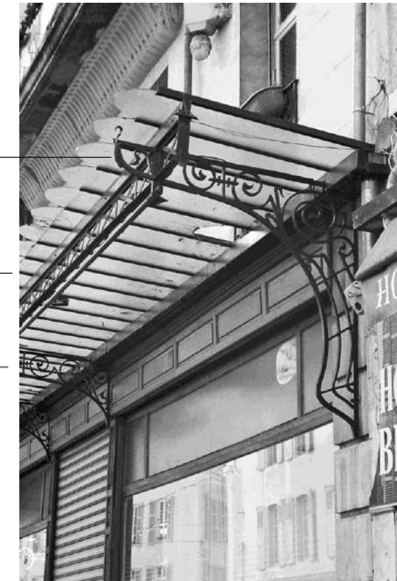
Détail de la marquise en ferronnerie
