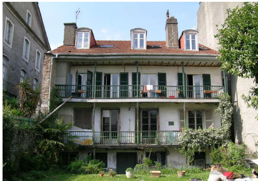
Rue Bayard, façade sur jardin avec galeries orientées au Sud
