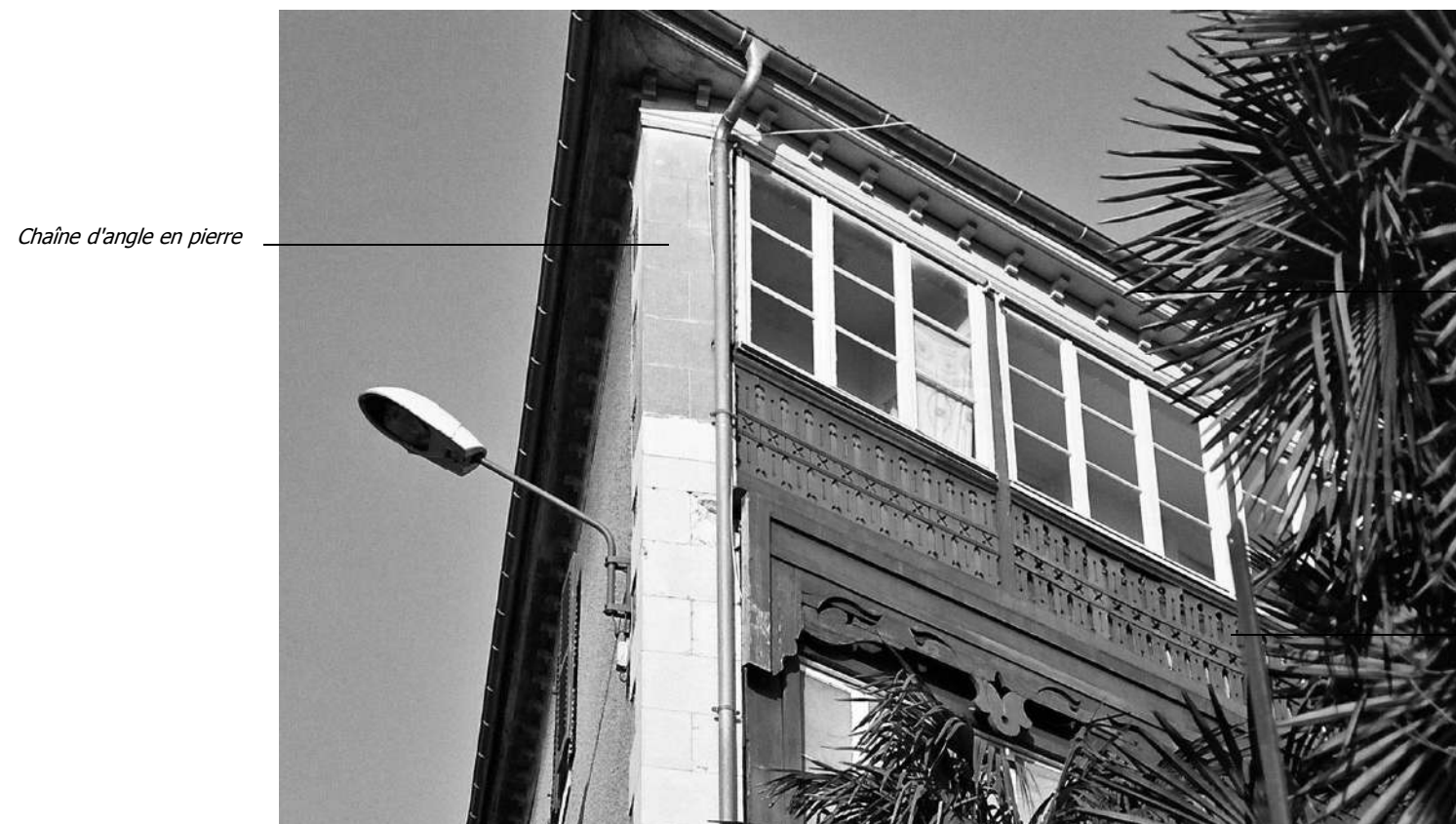
Corniche moulurée en bois peinte dans la même teinte que la modénature en pierre
