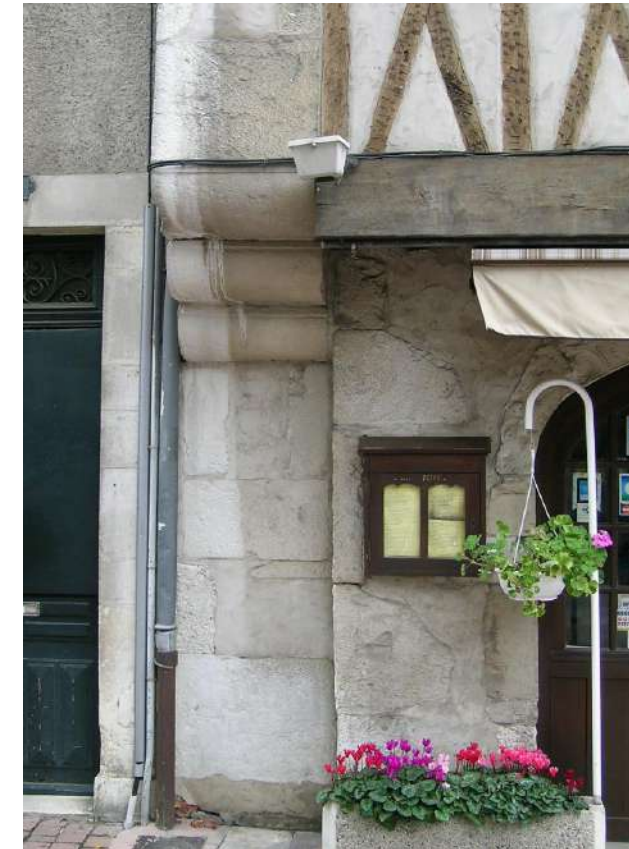
Autre exemple d'encorbellement avec corbeau en pierre sur un mur de refend en pierre. Rue du Château
