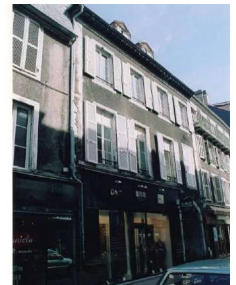
Menuiseries trop blanches
