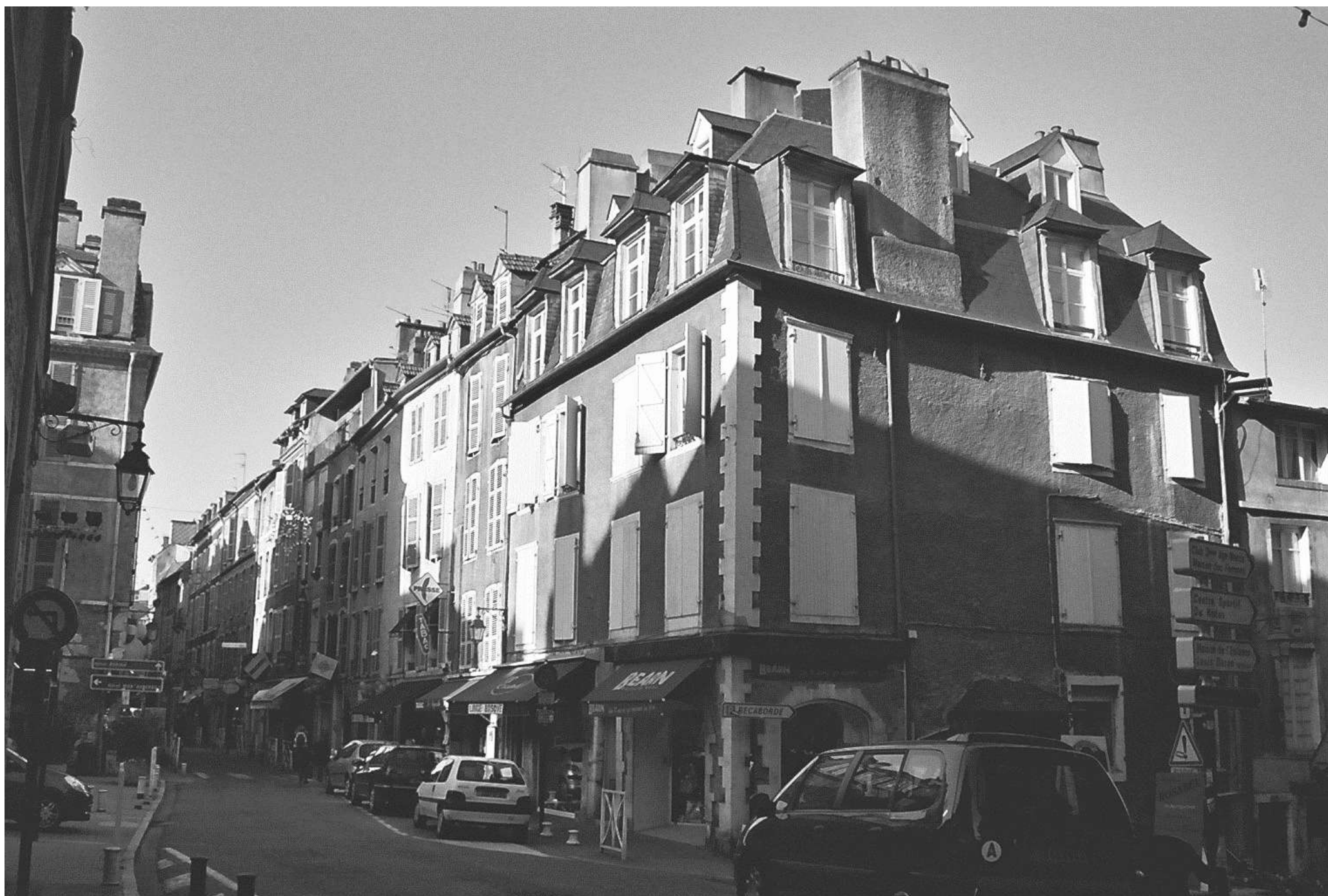
Vue sur l'angle de l'immeuble et l'enfilade des façades sur la rue Maréchal Joffre
