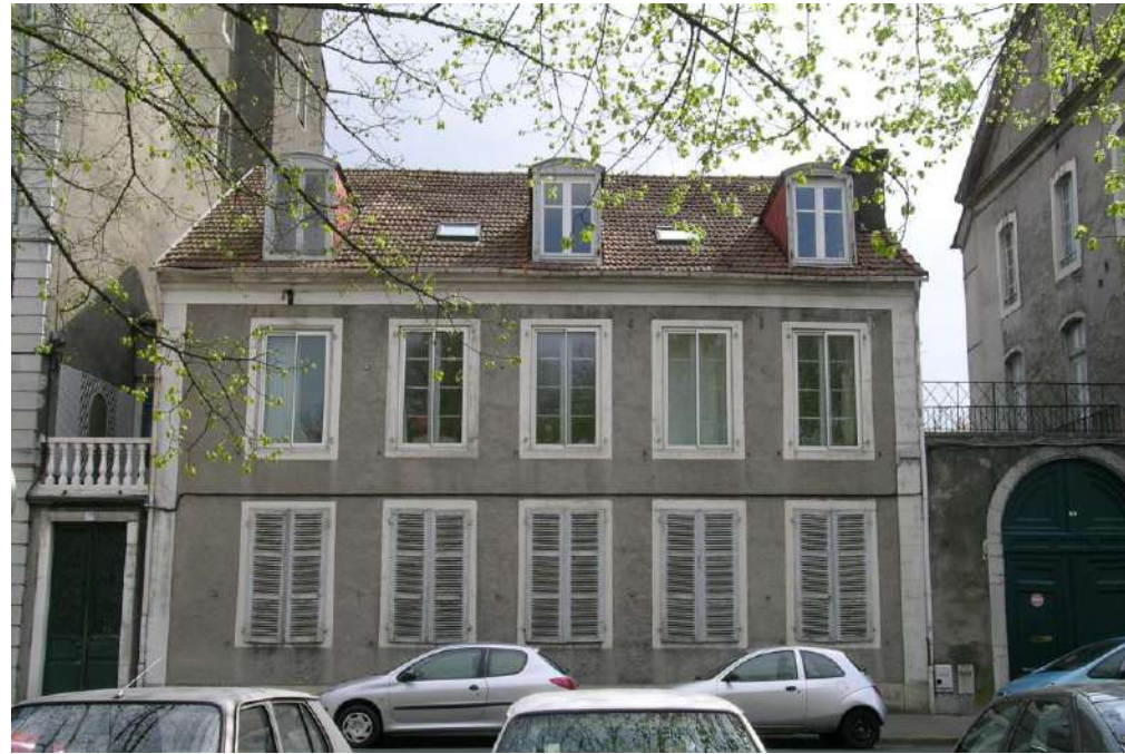
Rue Bayard, façade sur rue
