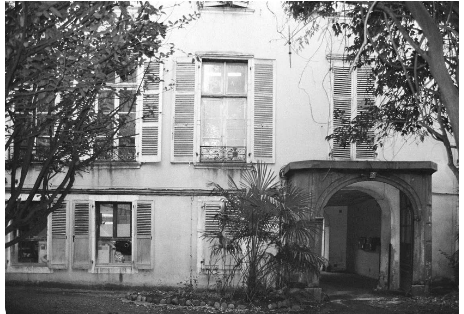
Photographies des façades sur cour : on peut remarquer qu'elles ont été un peu moins transformées que la façade sur rue, notamment l'aile en retour(photo de gauche) avec ses menuiseries à croisée en bois et à petits carreaux encore en place. Ces menuiseries peuvent servir de modèles pour une restitution sur la façade principale.
