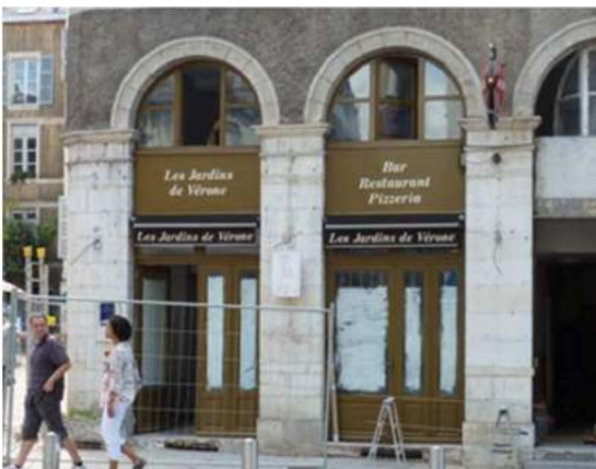
Exemple de devanture en « feuillure », entre rez de chaussée et entresol. Les baies de l'entresol épousent la forme de l'arc. L'enseigne prend place sur un coffre en bois.
