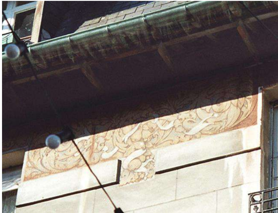
Détail du bandeau peint sous l'avant toit
