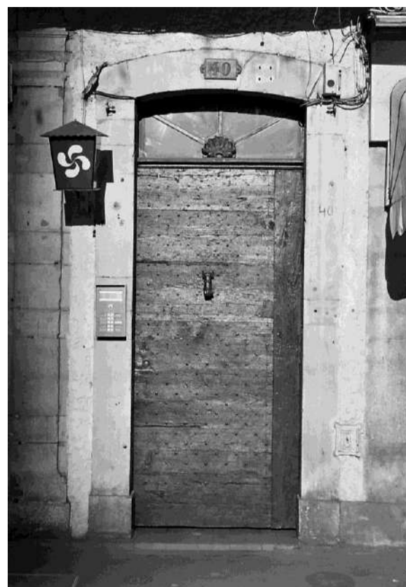
Type de menuiserie de porte à un battant en planche et contre planche, en bois peint. Imposte vitrée et heurtoir en fonte. Rue Maréchal Joffre
