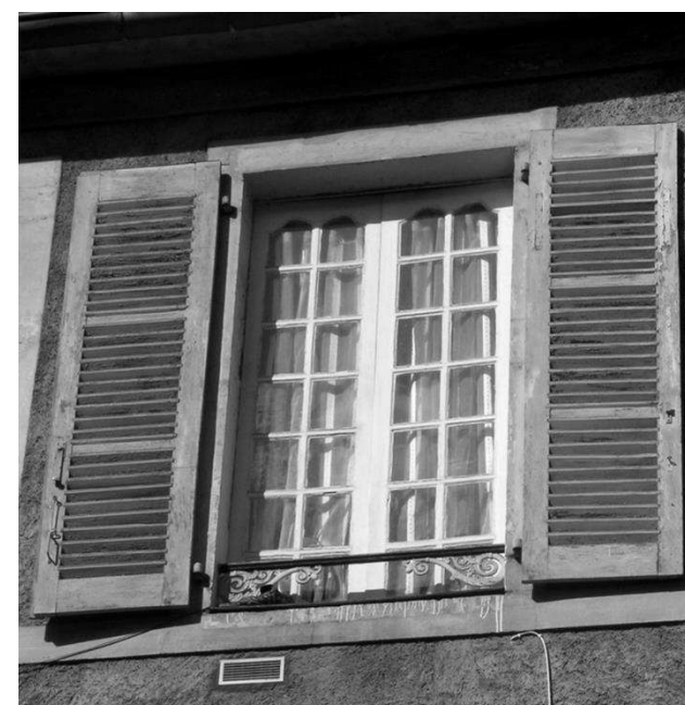
Type de menuiserie avec ouvrant à la française et petits carreaux. Le garde-corps et les persiennes ont été rapportés au XIX e siècle. Rue Henri IV
