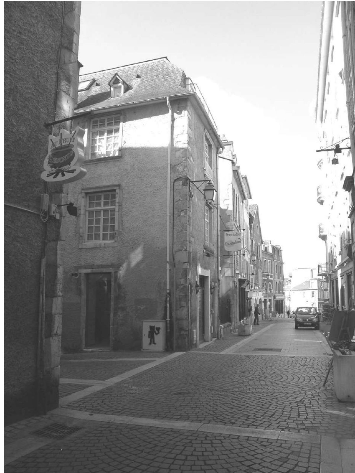
Angle de la rue et de l'impasse de Sully
