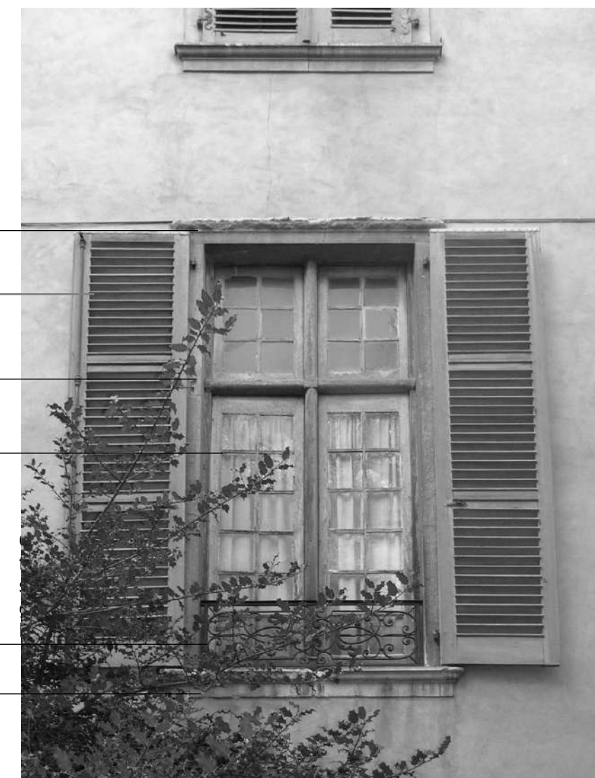
État actuel sur la cour
