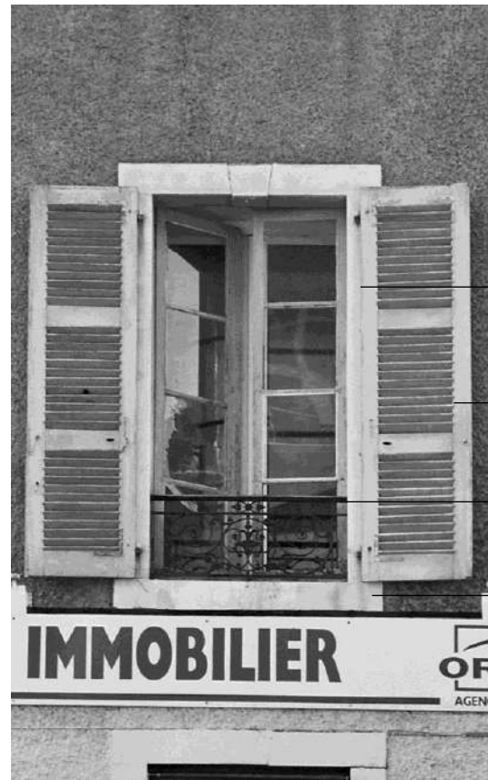
Menuiserie en bois à quatre grands carreaux
