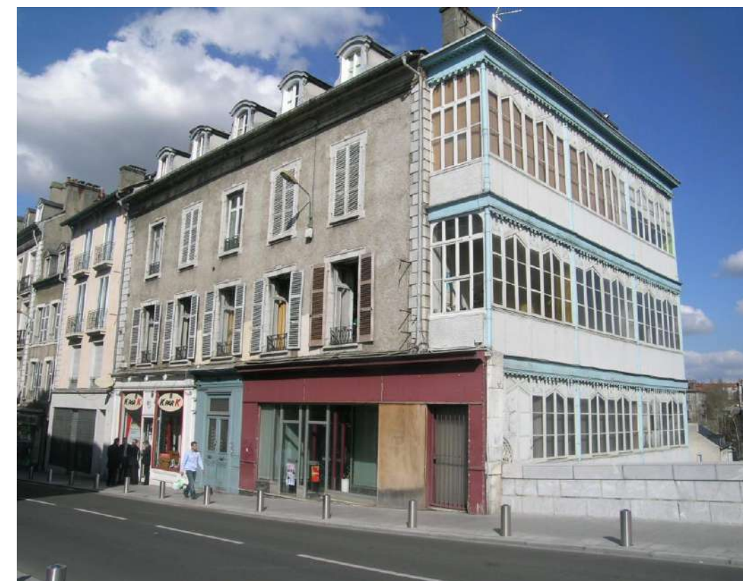
Rue Bordenave d'Abère, façade sur rue et façade sur le Hédas avec galeries en bois fermées et vitrées, orientées au Sud
