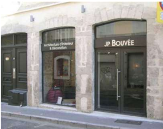
Exemple de devanture en « feuillure », réécriture contemporaine simplifiée mais qui respecte l'arc et la modénature du soubassement de l'immeuble et est composée avec la hauteur d'imposte de la porte.
