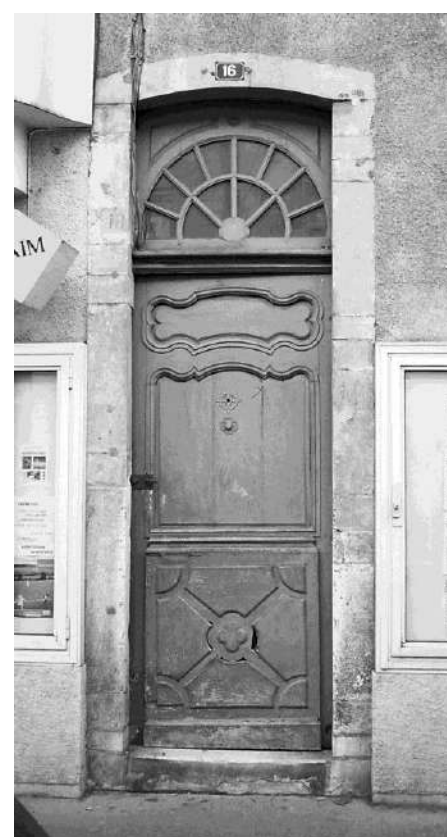
Type de menuiserie de porte à un battant en bois à moulure et peint. Imposte vitrée. Rue Maréchal Foch
