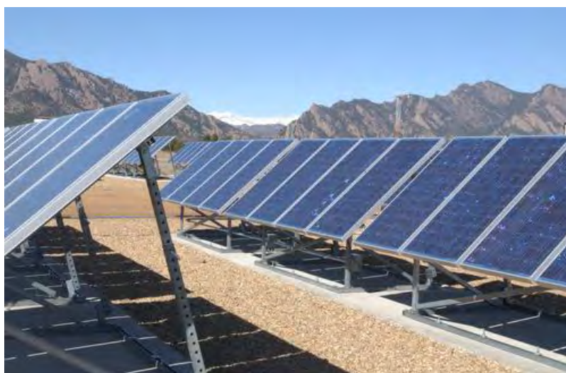
Figure 14 : Structure porteuse avec dalle en béton
