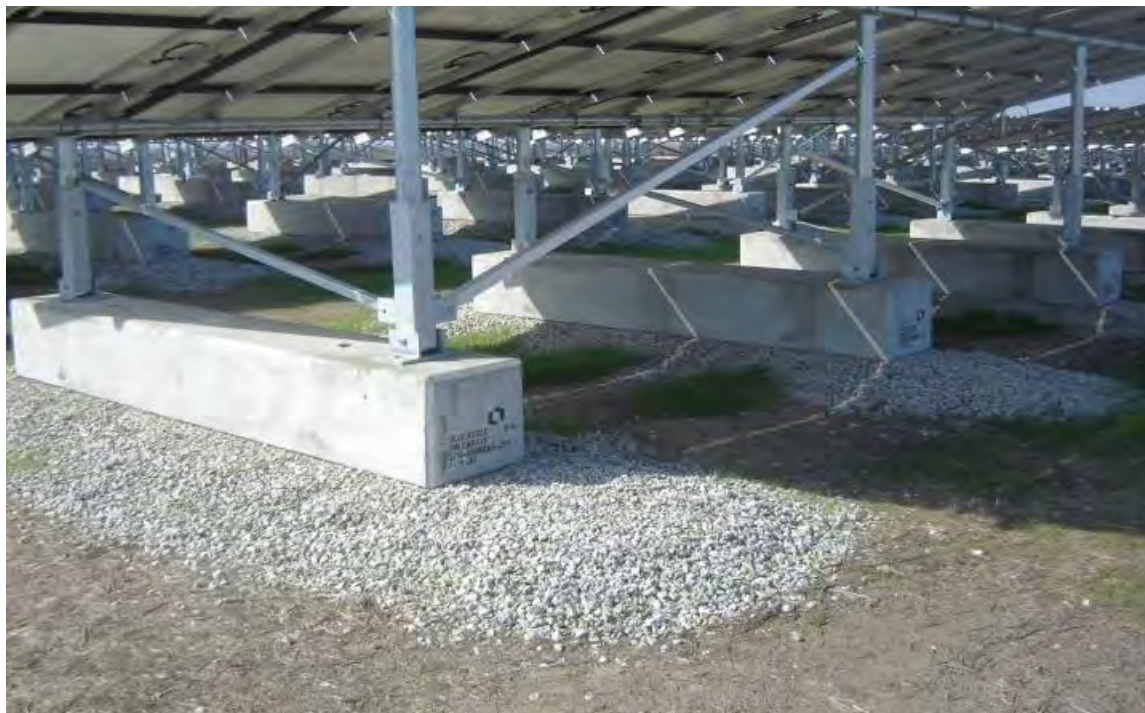
Figure 13 : Structure porteuse avec longrine en béton
