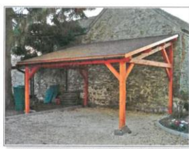
Abri de protection accolé à bâtiment (adjonction)
