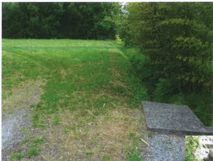
Photos n° 3, 4 et 5 : exutoire de la source (ouvrage) et la confluence avec le ruisseau Le Cazalé
