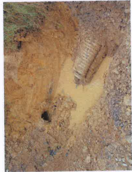
Ecartement de 1m80 des buses installées en 2009 + écrasement
