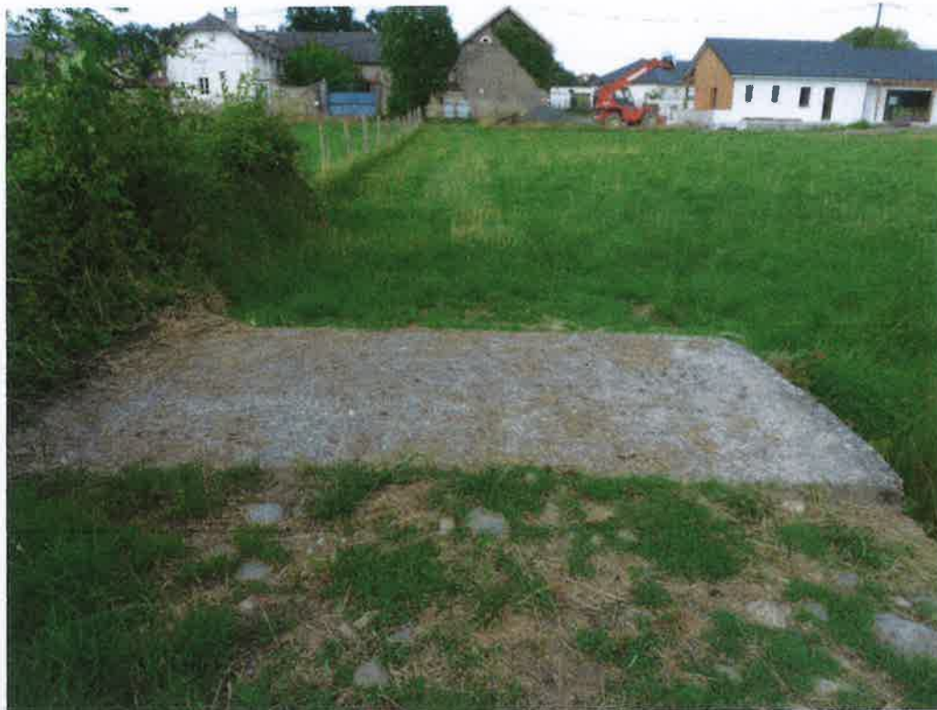
Photos N° 1 & 2 : pont en béton sur le ruisseau le Cazalé
