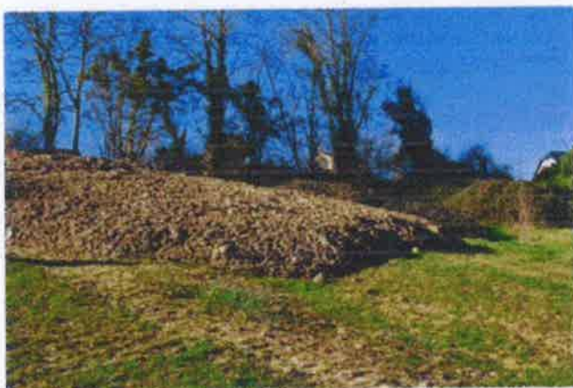
Partie avale du nouveau glissement. 4 interventions pour solutionner le glissement n'ont toujours pas permis de le stabiliser.
