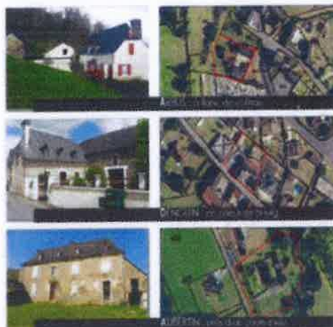
Fig 4- Exemple locaux de fermes sur cour ©CADERN d'Aménagement - photos CAPSP- 2018
