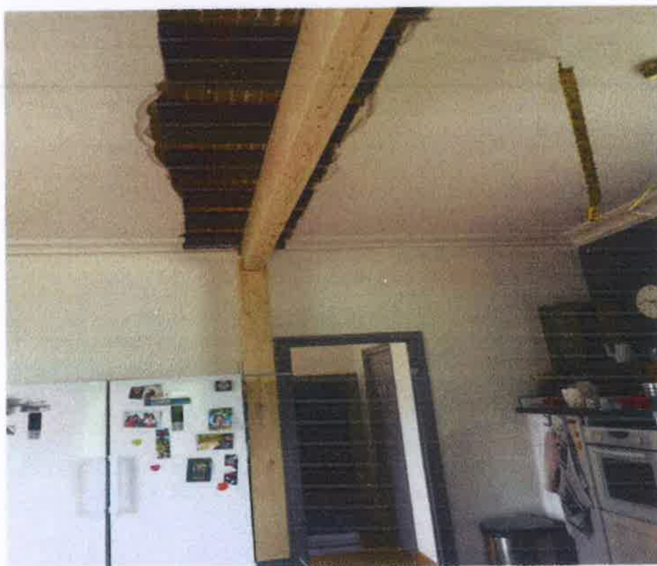
Travaux de renforcement effectués dans ma maison depuis la cave avec poteaux porteurs et poutre de maintien au niveau du bout de ma maison qui s'affaisse et se fragilise. Plus étais de renfort.
