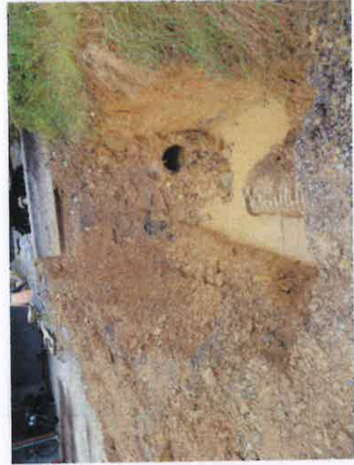
Ecartement de 1m80 des buses installées en 2009 + écrasement
