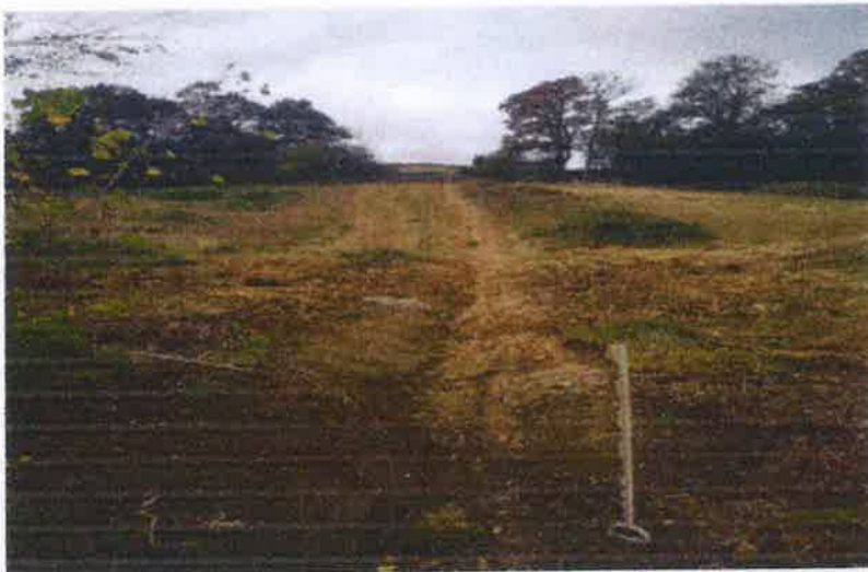
Drain provisoire posé pour évacuer l'eau du haut en direction de notre terrain.
