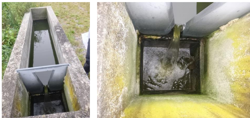
Figure 11 : Photos du canal de sortie
