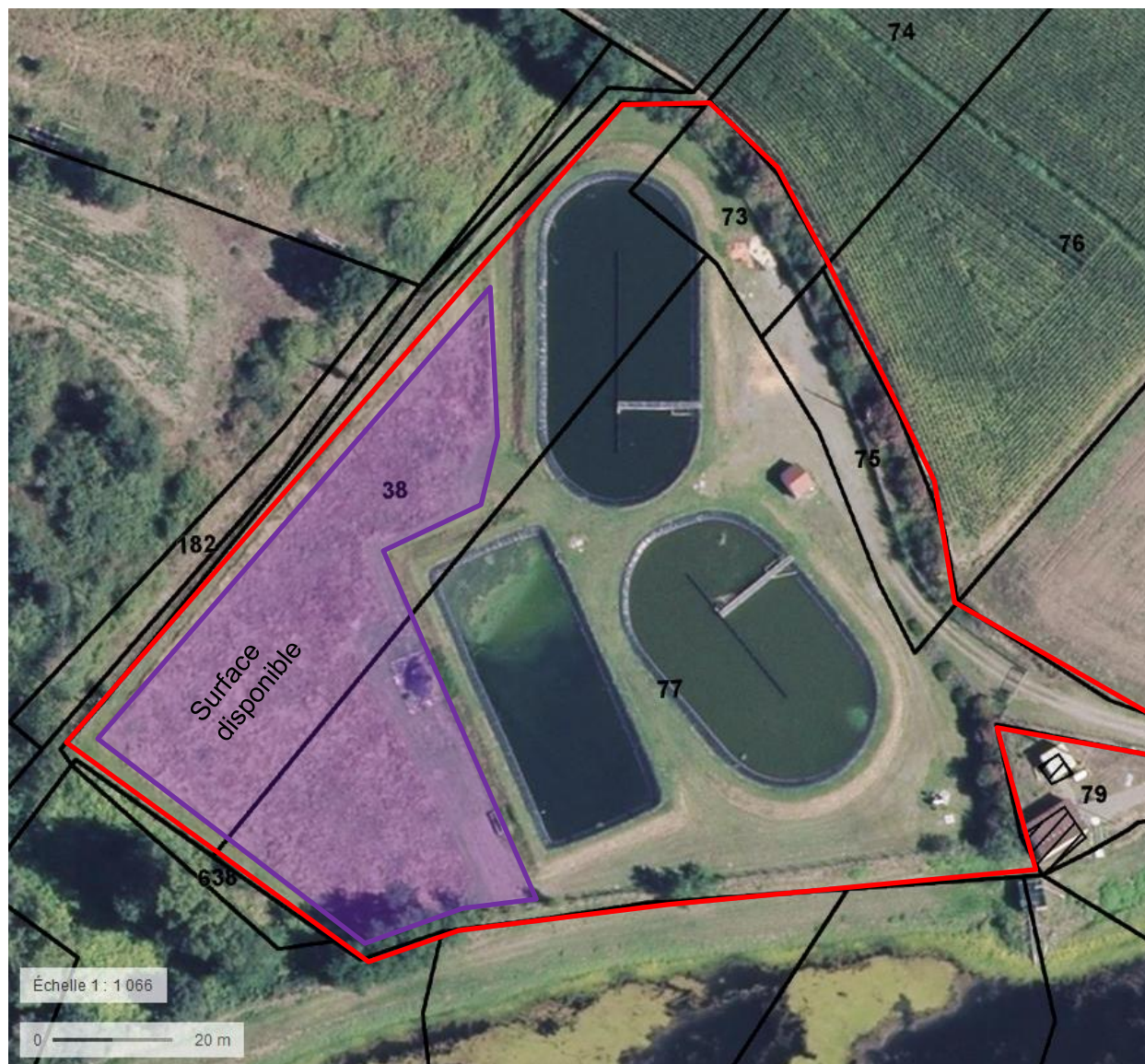
Figure 15 : Vue aérienne de la STEP
