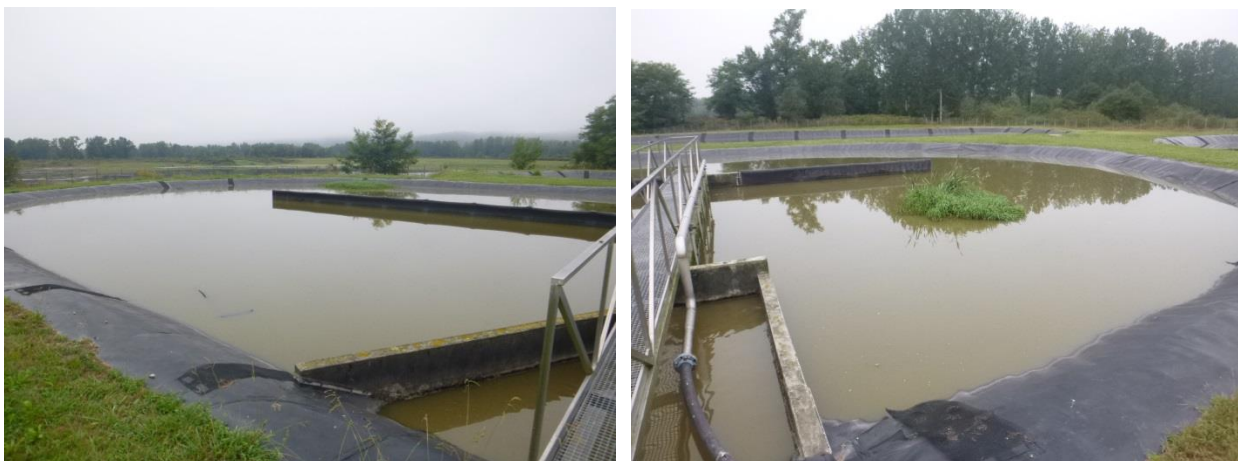
Figure 9 : Photos des lagunes aérées
