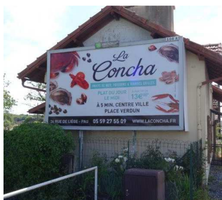
Structure épaisse masquant un montage anormal
