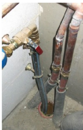
Exemple d'entrées de réseaux à calfeutrer
