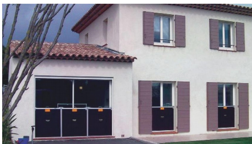
Exemple de protections des ouvertures
