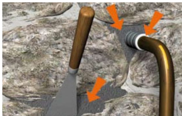
Situation après travaux de colmatage
