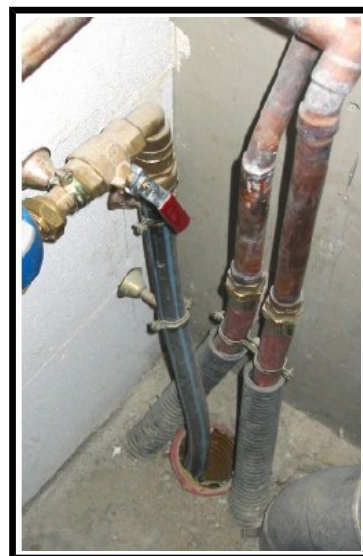
Calfeutrage des entrées de réseaux
