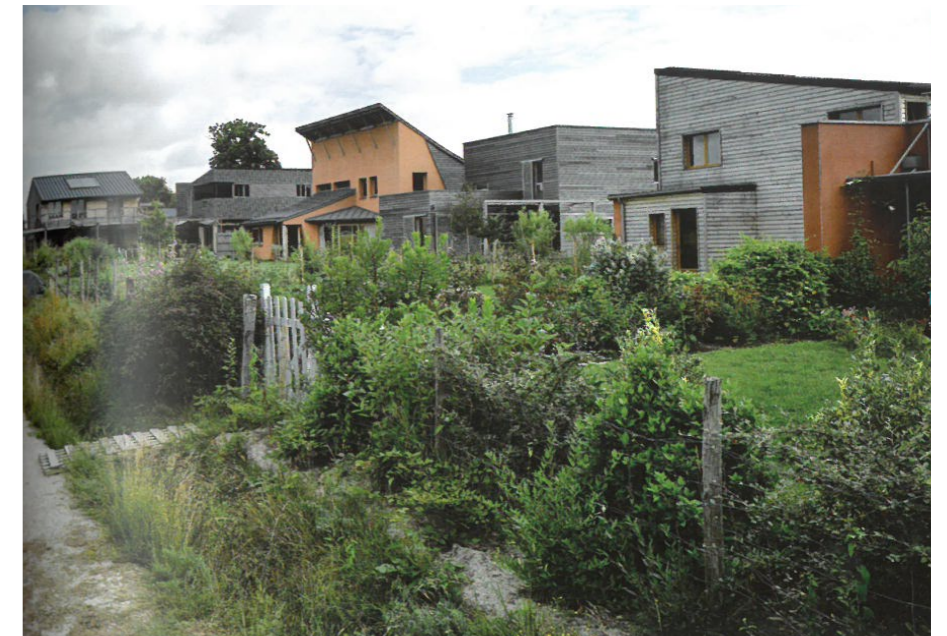
Des fossés paysagers et ouverts qui permettent une gestion écologique des eaux de pluie, Edé-Bazouges
