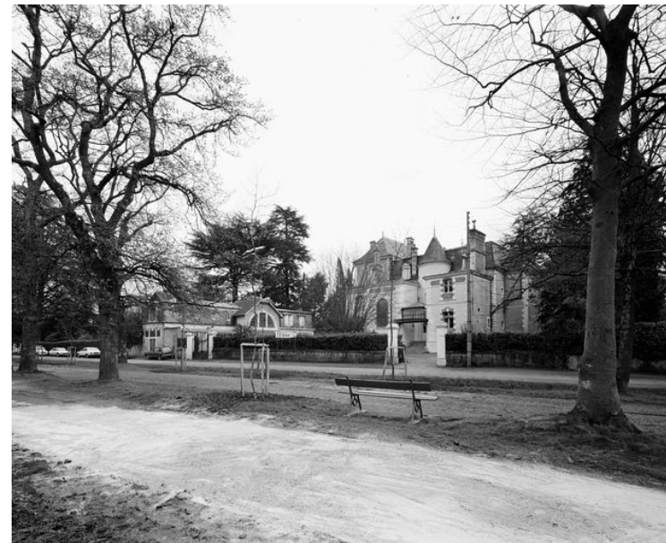
Fig 2 et 3. Villas Augusta, 1977 et L'étrier, 1978, démolies - PAU (c) Région Nouvelle-Aquitaine, Inventaire général - CHABOT Bernard, DUBAU Michel
