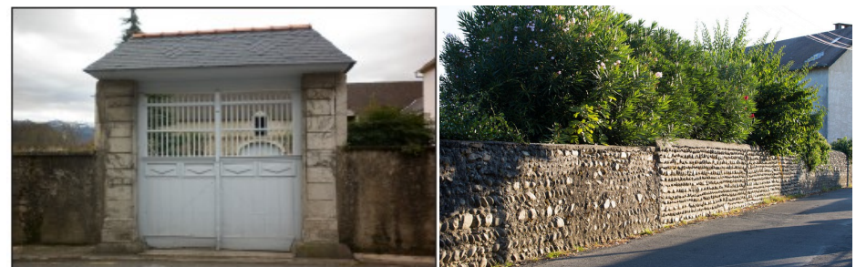
Fig. 18 & 19– Exemple de portail et de mur de clôture © CAUE64- Anne-Cécile ESTEVE
