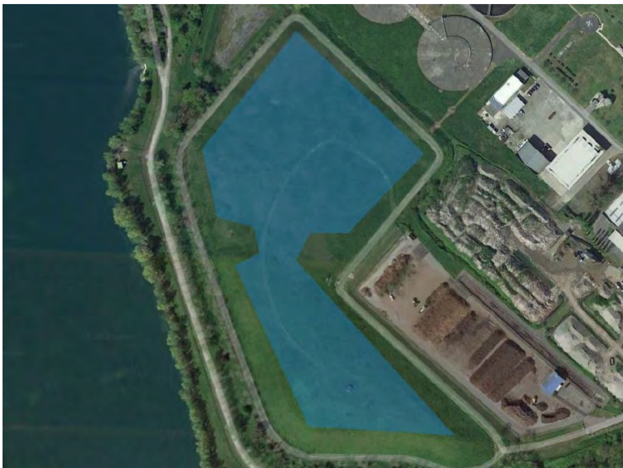
Figure 6. Surface utile pour l'implantation de la centrale photovoltaïque (Source : BURGEAP)
