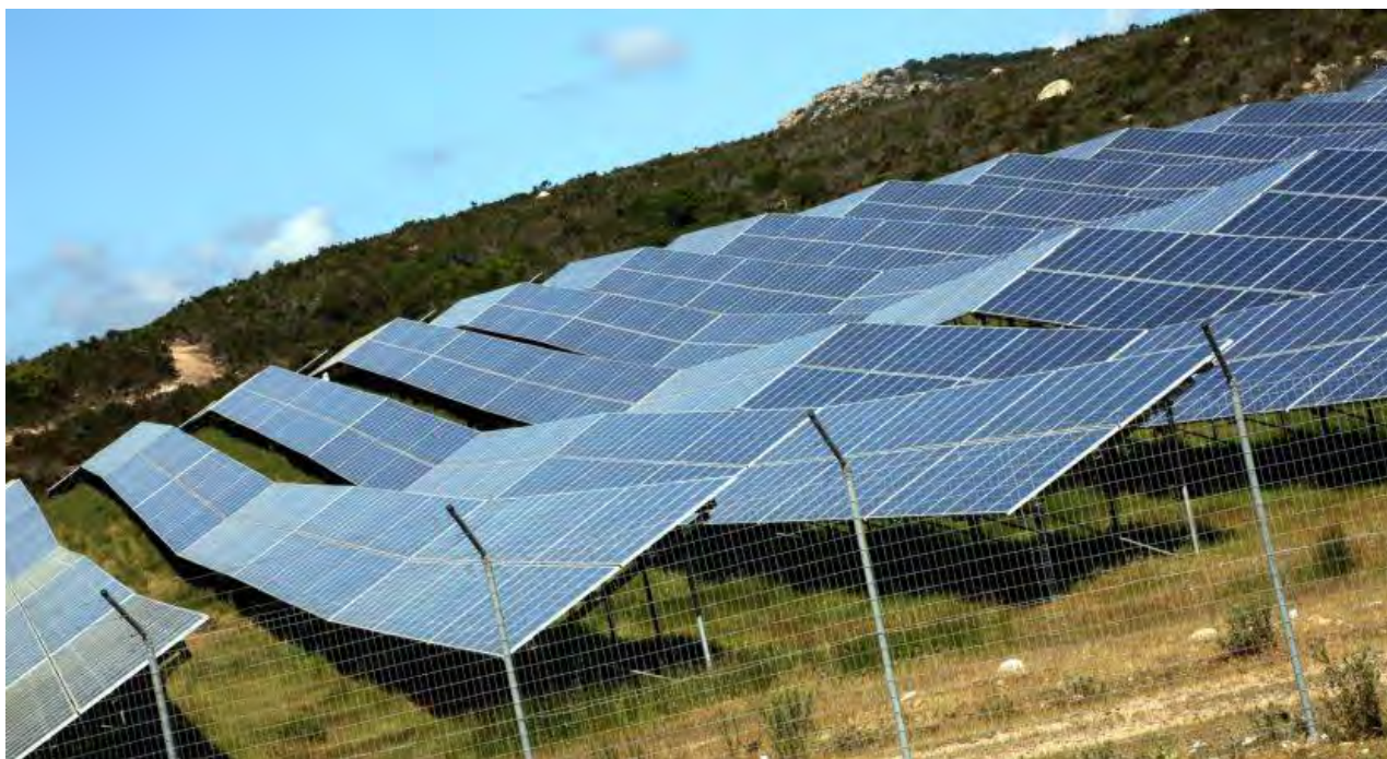
Figure 12 : Exemple de disposition des modules en table (positionnement des modules en mode portrait), avec deux modules en hauteur et vingt modules en longueur
