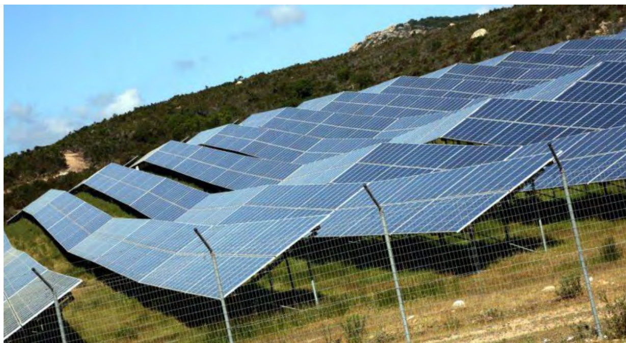
Figure 10. Exemple de disposition des modules en table
