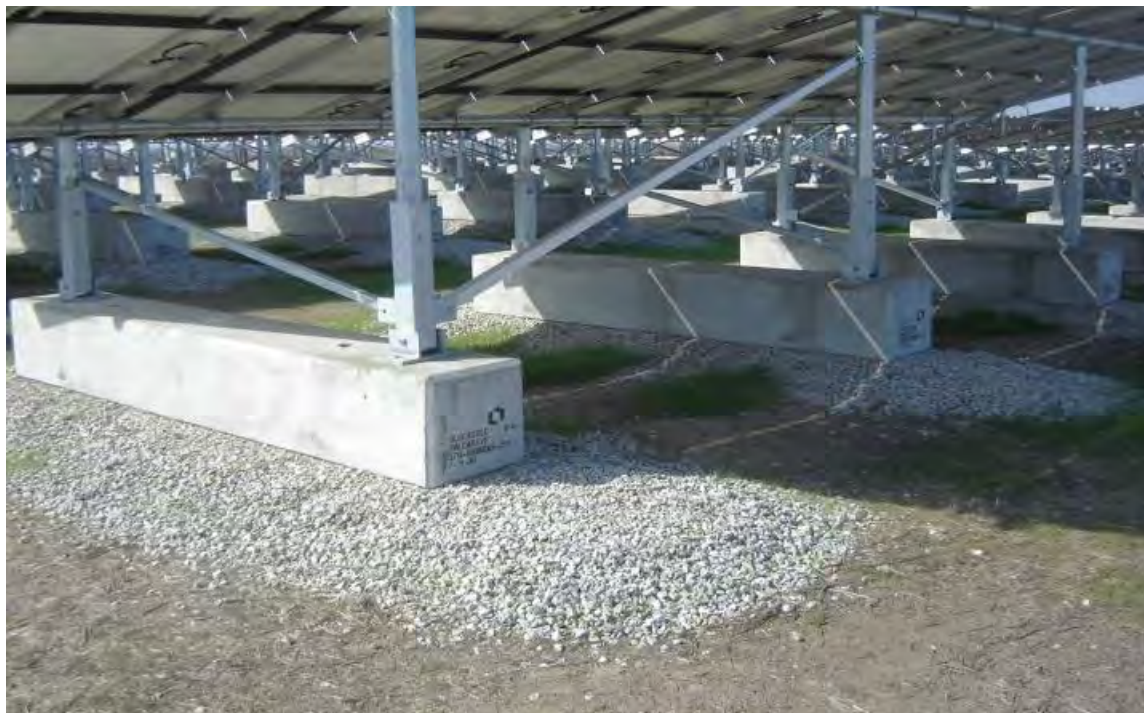
Figure 13 : Structure porteuse avec longrine en béton
