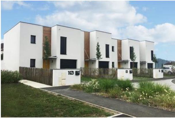
Billère, Béarnaise Habitat (Photo : Camborde Architectes)
