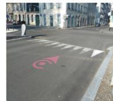
une matérialisation au sol
