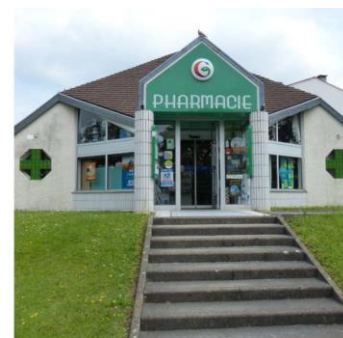
Lons - Le Perlic, une centralité aménagée et équipée
