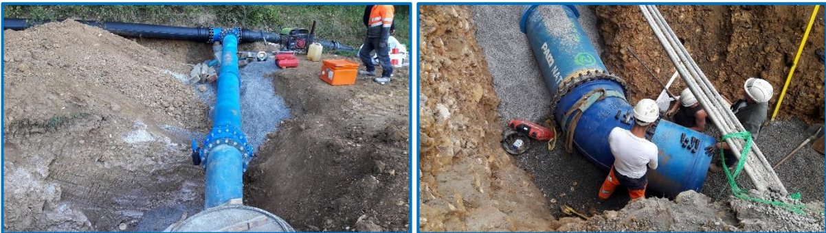
Figure 9. Pose et raccordement du réseau d'adduction
