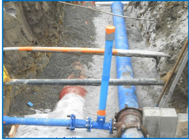
Figure 8. Travaux de renouvellement de réseaux
