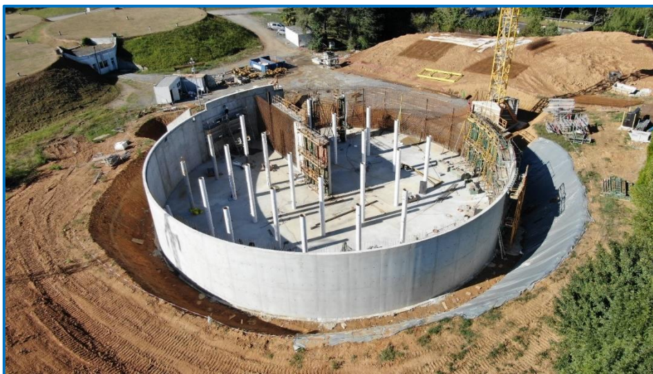
Figure 12. Travaux du futur réservoir de Guindalos en 2020
