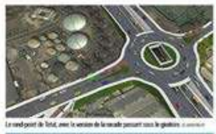
Le rond-point de Total, avec la route de la rocade passant sous le giratoire.
