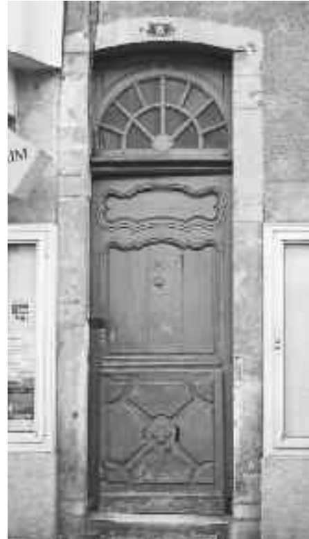
Type de menuiserie de porte à un battant en bois à moulure et peint. Imposte vitrée. Rue Maréchal Foch
