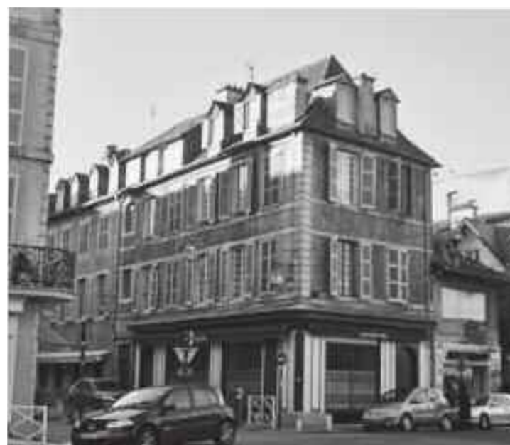
Grande maison à l'angle de la rue Henri IV et la rue Gassion. éléments de modénature (encadrements, bandeaux, chaîne d'angle en enduit et peinte) et les menuiseries de fenêtres des étages et des lucarnes sont encore en place. Le rez de chaussée a été remanié au XIX ème siècle avec l'ajout d'une devanture en bois.
