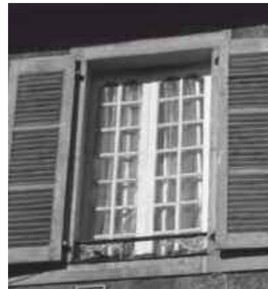
Type de menuiserie avec ouvrant à la française et petits carreaux. Le garde-corps et les persiennes ont été rapportés au XIX ème siècle. Rue Henri IV
