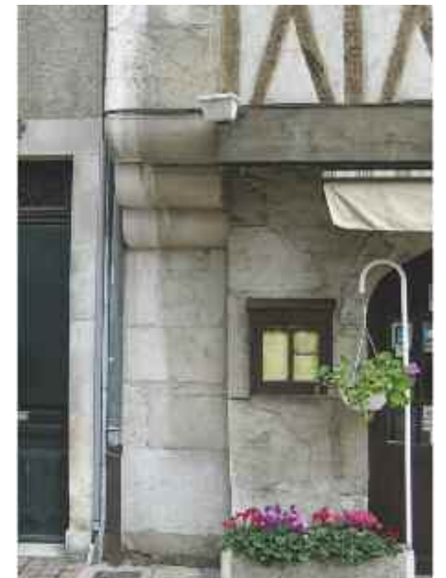
Autre exemple d'encorbellement avec corbeau en pierre sur un mur de refend en pierre, rue du Château.
