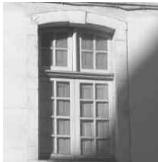
Type de menuiserie avec une croisée en bois en partie haute et ouvrant à la française en partie basse. Couvrement par un arc cintré en pierre avec clef pendante. Les volets intérieurs ont été conservés. Place Saint Louis de Gonzague
