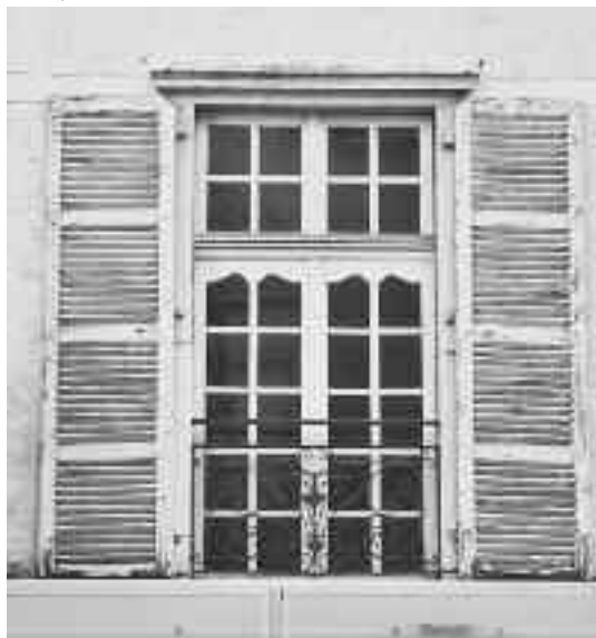
Type de menuiserie avec une croisée en bois en partie haute et ouvrant à la française en partie basse. Linteau plat en pierre moulurée et ferronnerie de garde-corps à volutes. Rue Maréchal Joffre
