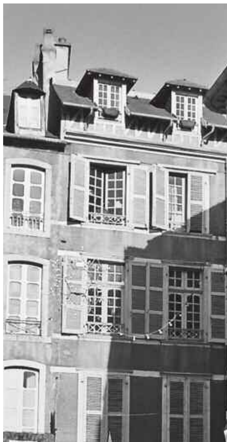
Type d'immeuble à façade étroite sur la rue Joffre : la composition et les éléments de modénature sont encore en place, encadrements, menuiseries des fenêtres, bandeaux.
