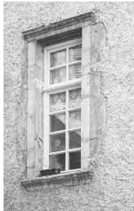
La fenêtre étroite : état actuel
