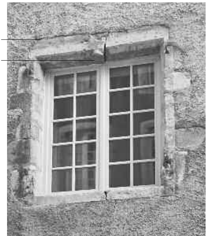
La fenêtre : état actuel
