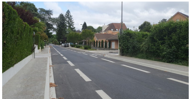
Après les travaux
