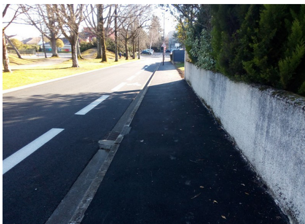
Après les travaux
