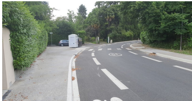
Après les travaux
