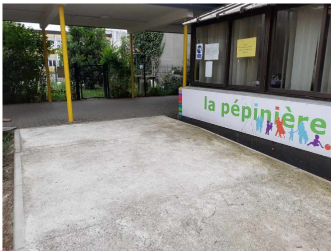
La rampe d'accès
