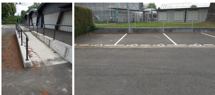
La rampe d'accès Et les places de stationnement – J. d'Albret
